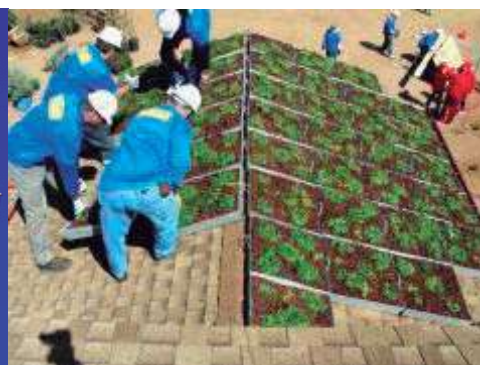
IMAGEN 26. Instalación de una cubierta verde.
