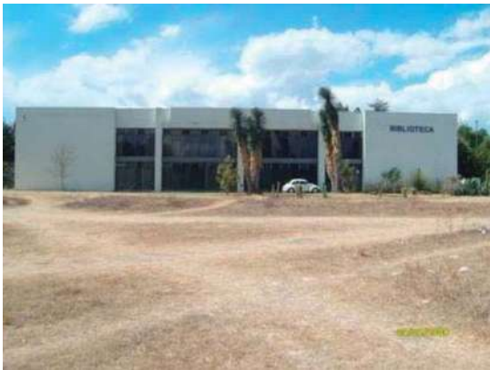
Fachada oriente de la biblioteca SE OBSERVA UNA FACHADA COMPUESTA CON CRISTAL Y CONCRETO, UNA FACHADA SIMETRICA Y POCA VEGETACION.
