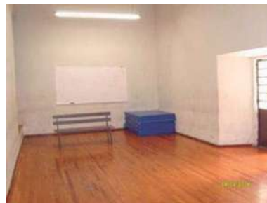
SALON PARA DANZA, SE OBSERVA QUE ES ESTRECHO Y CARECE DE VESTIDORES Y REGADERAS.
