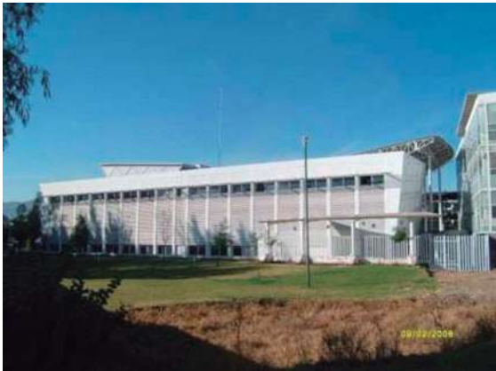
Fachada oriente del edificio de Arquitectura SE APRECIA AL MANEJO DE DIVERSOS MATERIALES PARA LA COMPOSICIÓN DEL EDIFICIO COMO CRISTAL, CONCRETO Y ALUMINIO, ASÍ COMO LA REPETICIÓN EN SUS VENTANAS, PROTEGIDAS POR LOUVERS.
