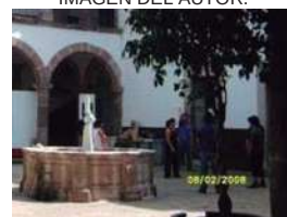
PATIO CENTRAL Y FUENTE. IMAGEN DEL AUTOR.
