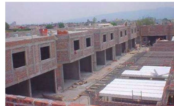
MUROS DE PANEL TIPO "W"
