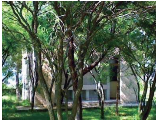
Imagen 6: baños en muy mal estado físico, ubicados en medio de la zona arbolada 32
