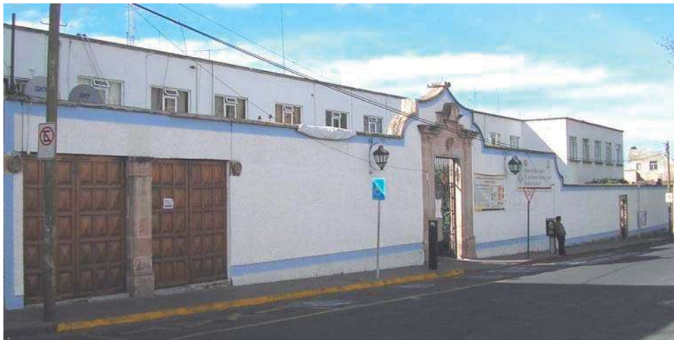
3.44 Fotografía actual del edificio de la Clínica de Salubridad, en primer plano en la parte inferior izquierda se observa un acceso que no formó parte del proyecto original así como el volumen de planta alta que se observa en la parte superior derecha de la imagen.
