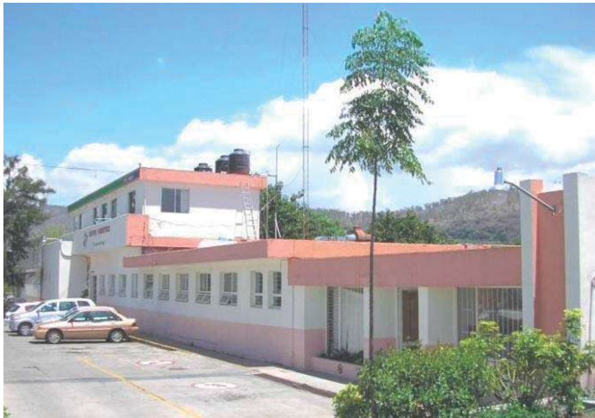
3.59 Fotografía actual de la fachada principal del Hospital Psiquiátrico, en la cual se observa el segundo piso correspondiente al área administrativa que no formó parte del proyecto original.
