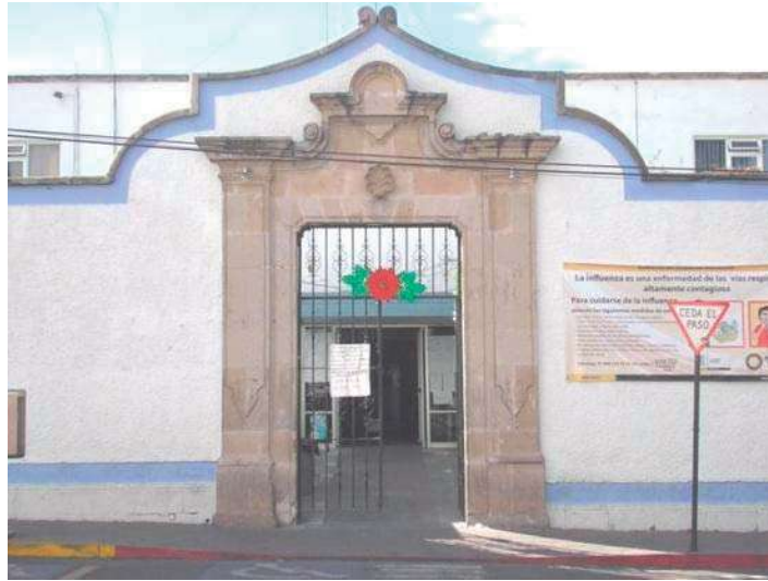
3.45 Fotografía actual del acceso principal de la Clínica de Salubridad donde se observan los detalles de cantera en marco y cornisas que ayudaban al edificio a integrarse con el contexto del centro histórico de Morelia, así como los aplanados lisos y de colores discretos de los muros.
