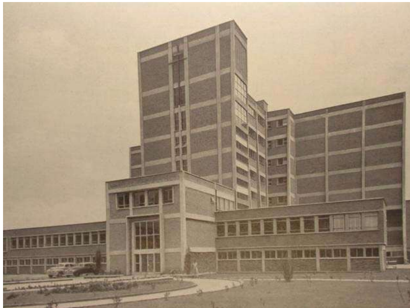
2.08 Hospital Manuel Gea González en la ciudad de México (1942), una de las mayores características de los modelos hospitalarios norteamericanos implementadas en los hospitales mexicanos fue el “hospital rascacielos”, un edificio en vertical optimizaba el espacio predial y acortaba recorridos.
