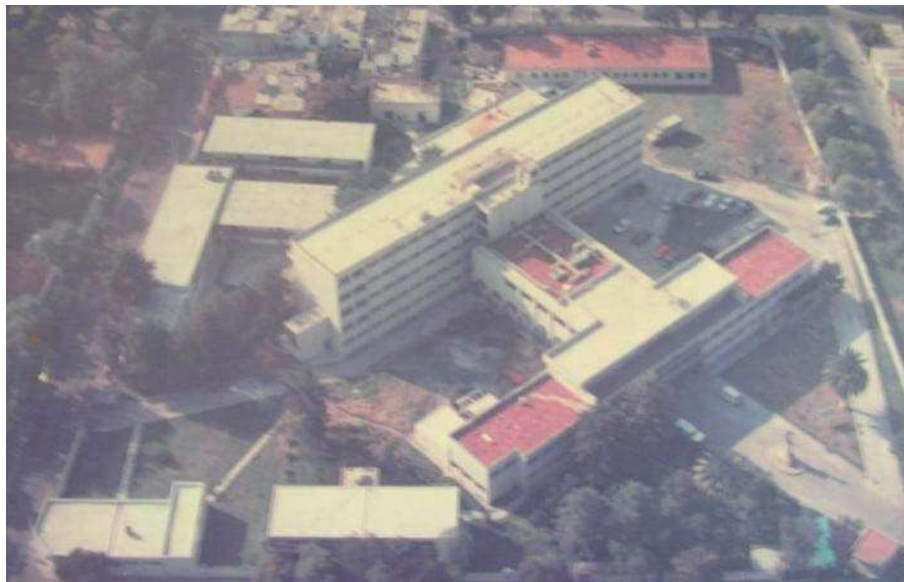
3.23 Fotografía aérea del Hospital Civil de Morelia años después de su inauguración, en la que se puede apreciar la forma general del edificio y algunas de las primeras modificaciones.
