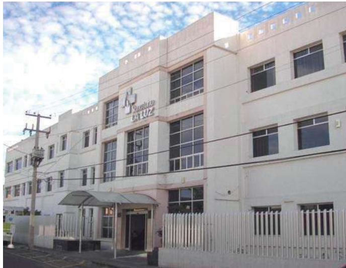
4.07 Fotografía actual del Sanatorio La Luz en la que se observa la jerarquización del acceso principal mediante un volumen que sobresale del resto del edificio a pesar de la homogenización de texturas y colores. Fotografía: Eder García Sánchez.
