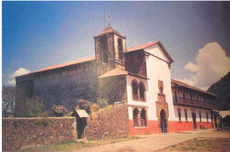
1.06 Imagen del hospital para naturales en Angahua, Michoacán. La influencia religiosa en los hospitales de la época virreinal es evidente en sus construcciones las cuales generalmente eran anexos de alguna otra construcción religiosa como capillas, conventos o monasterios.
