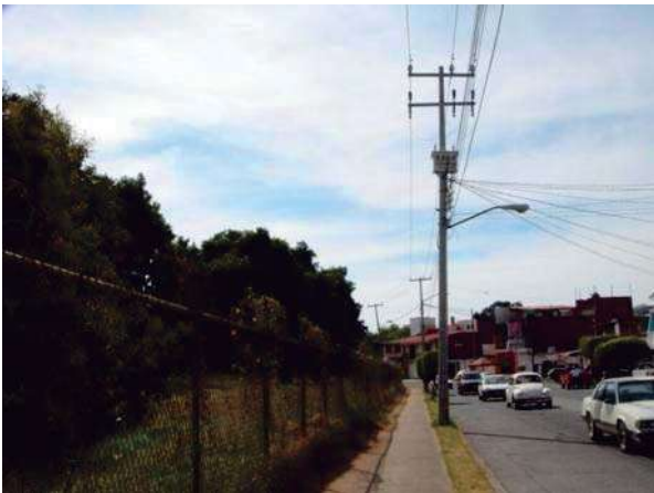
Imagen 2 Vista del Terreno, frente Oeste. Se observa la línea de CFE y el transformador. Foto por Leslie Edith Alejo Guerra
