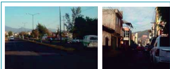
078 CALZADA 16 De SEPTIEMBRE y ALLENDE SUR // FJAC
