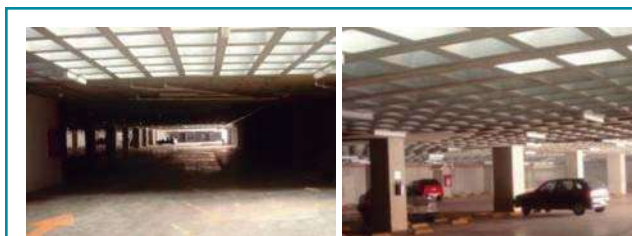
043 ESTACIONAMIENTO CENTRO REGIONAL DE LAS ARTES / ZAMORA MICH. // FJAC
