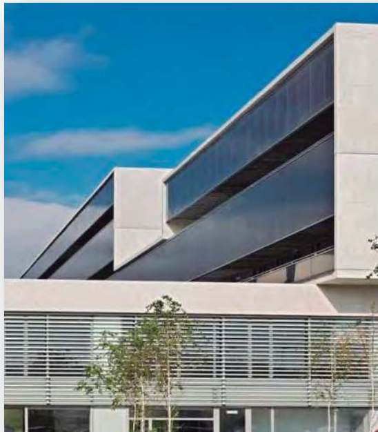
FIG 62 Edificio de Oficinas de Tracasa, Navarra, http://www.arkinetia.com/Breves/art560.asp
