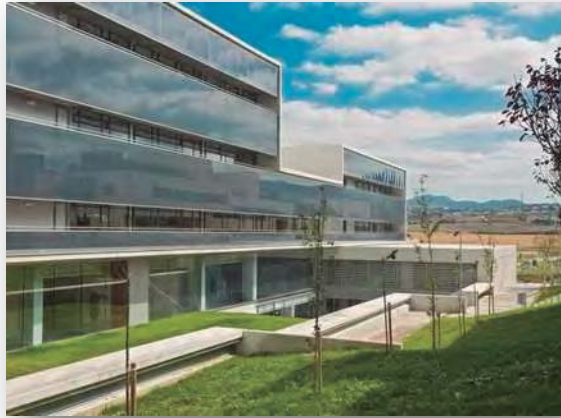
FIG 61 Edificio de Oficinas de Tracasa, Navarra, http://www.arkinetia.com/Breves/art560.aspx
