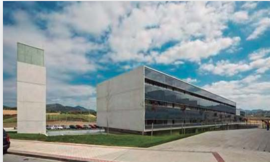
FIG 63 Edificio de Oficinas de Tracsa, Navarra, http://www.arkinetia.com/Breves/art560.asp
