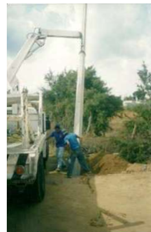
Hincado de postes de concreto de 12
