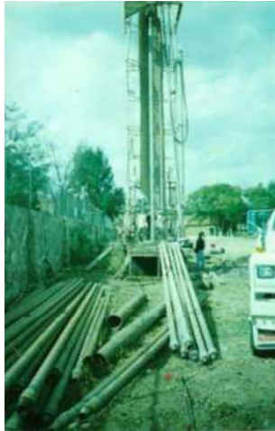
Perforación de Pozo
