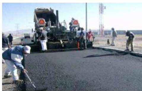
Tendido y compactado de carpeta asfáltica
