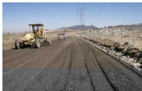
Vista de extendido y afinado de capa de base con motoconformadora
