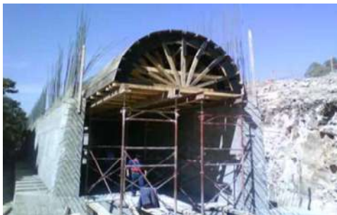
Obra Privada construcción de bóveda en la Av. Amalia Solórzano de Cárdenas
