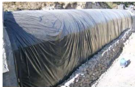
Imágenes que muestran el sello de hule y el muro seco de piedra del lugar
