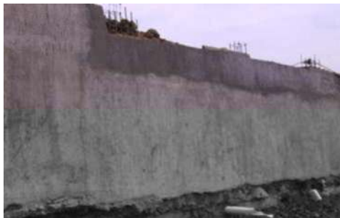
Aplanado en muro de contención
