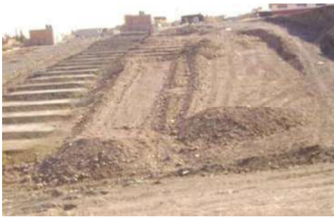
Vista de excavación para mejoramiento de terreno
