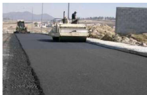
Tendido y compactado de carpeta asfáltica
