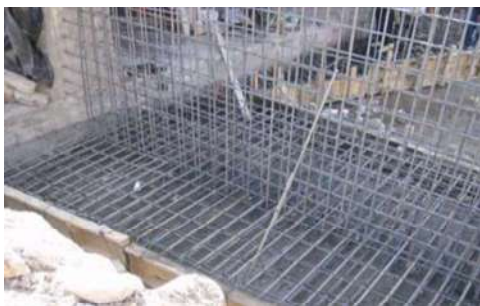
Detalle del armado de zapata y muro de aleros de bóveda
