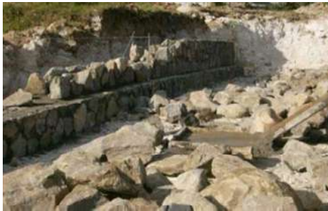
Construcción de muros de mampostería con piedra de la región
