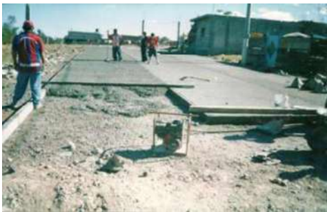
Pavimentación de la Calle Verde Prado Col. Ampl. Praderas del Sur
