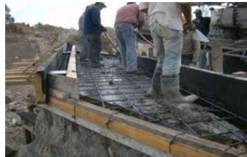
Vista del armado, cimbrado y colado de losa de concreto en paso de alcantarilla
