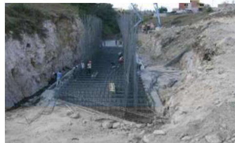
En esta imagen se observa el armado en cimentación y el anclaje para los muros de la bóveda
