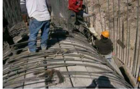
Armado de bóveda con varillas de diferentes diámetros
