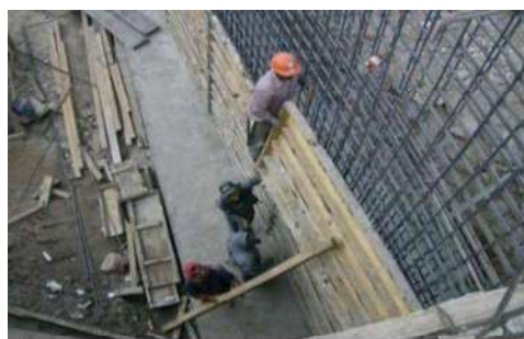
Vista del cimbrado de muro de alero de bóveda y colado de zapata de aleros de bóveda
