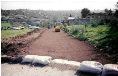
Compactación de base hidráulica
