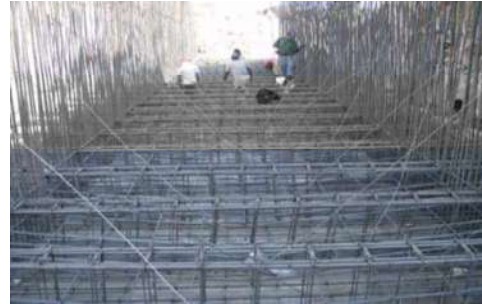
Vista del armado en trabes y cimentación
