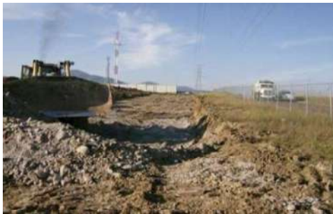
Corte del terreno con tractor D8
