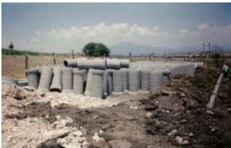
Apoyo con tubería de concreto para drenaje sanitario
