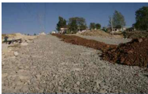
Acarreo de material de base
