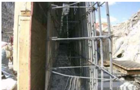
Detalle del armado del muro
