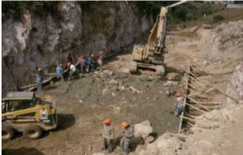
Vista del cimbrado y colocación de piedra en plantilla de cimentación
