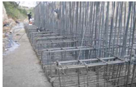
Vista del armado parcial de las contratrabe
