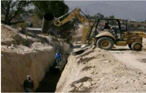
Imágenes que muestran la colocación de la tubería con la retroexcavadora y de la tubería ya instalada con su acostillamiento
