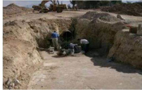
Imágenes que muestran la colocación de la tubería con la retroexcavadora y de la tubería ya instalada con su acostillamiento
