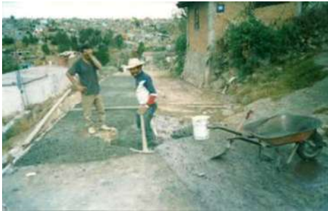
Colocación de concreto hidráulico
