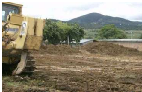
Terreno despallado con maquinaria
