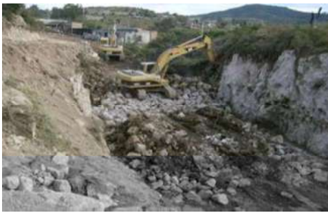
Excavación con máquina excavadora con martillo hidráulico
