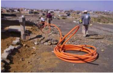
Colocación de ductos para línea de baja tensión
