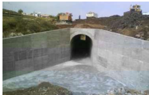
Obra Privada construcción de bóveda en la Av. Amalia Solórzano de Cárdenas
