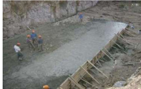
Vista del colado de concreto en plantilla de cimentación
