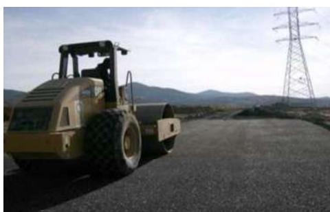
Compactado de base hidráulica
