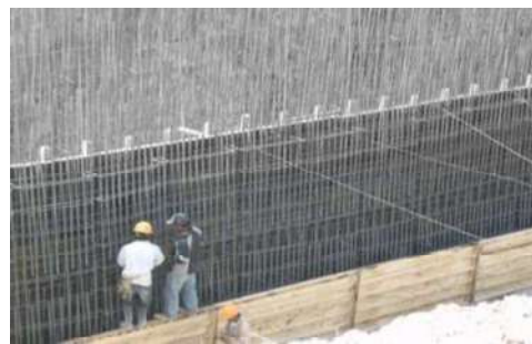
Cimbrado del muro de bóveda
