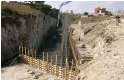
Vista del armado y cimbrado de cimentación y muros
