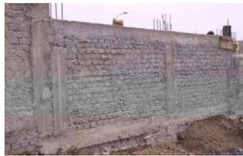
Muro de contención de tabicón
