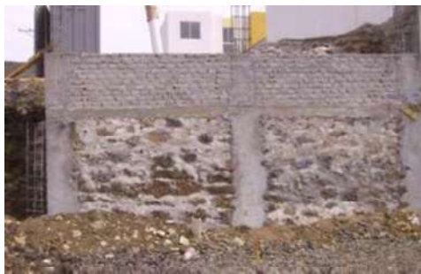
Vista de muro de contención
