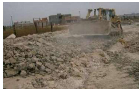
Tendido de la capa de filtro
