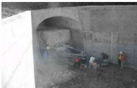
Vista general de aleros terminados en entrada y salida de bóveda
