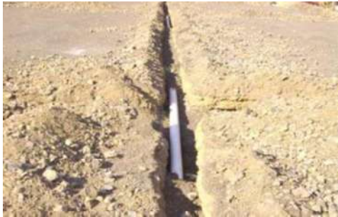
Colocación de tubería de P.V.C.
