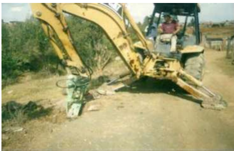
Excavación con el uso de retroexcavadora para colocación de postes de concreto
