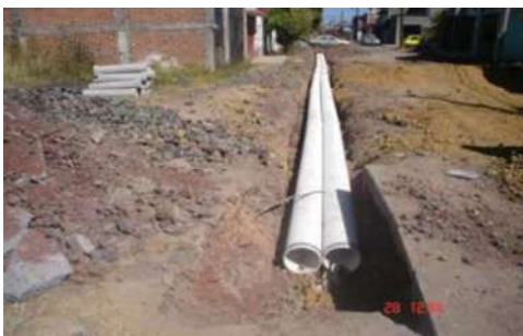
Colocación de tubería de PVC
