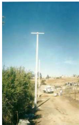
Postes de concreto listos para vestirse
