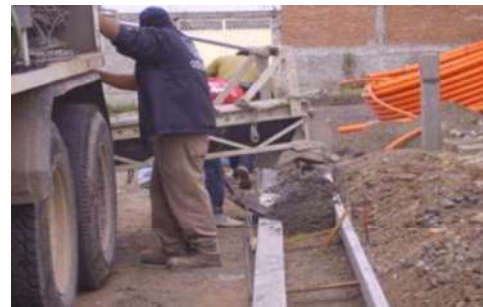
Colocación de concreto en guarnición
