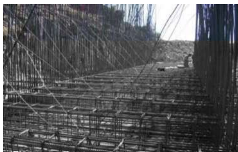
Vista del armado en cimentación
