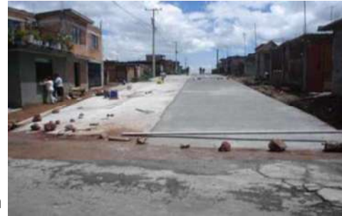
Calle Manzana terminada
