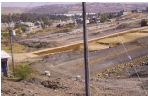
Vista de tendido de base hidráulica
