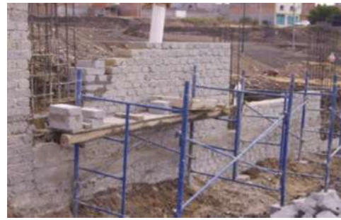
Muro de contención
