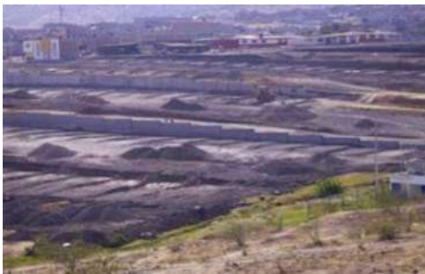
Vista de construcción de plataformas
