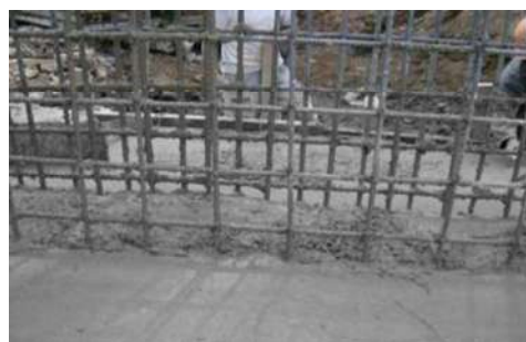
Vista del cimbrado de muro de alero de bóveda y colado de zapata de aleros de bóveda
