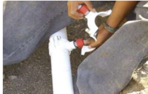
Colocación de hidrotoma domiciliaria
