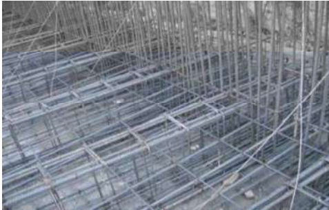
Vista del armado en trabes
