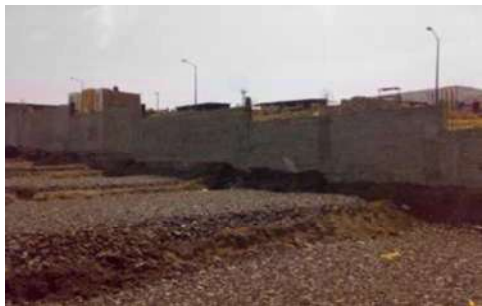
Vista de plataformas y muro de contención
