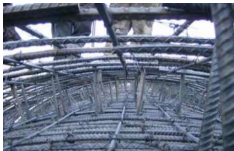
Detalle del armado de arco de bóveda
