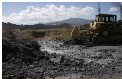
Despalme de terreno con el uso de zanjadora de tractor D8
