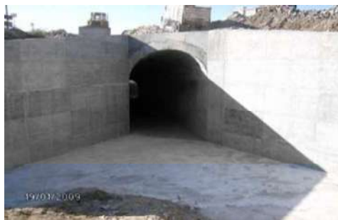
Vista general de aleros terminados en entrada y salida de bóveda
