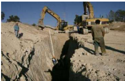
Detalles del trabajo de excavación con excavadora en profundidades mayores de 3.00 mts.
