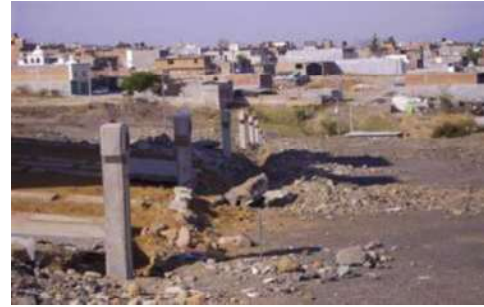
Vista general de los muretes de medición
