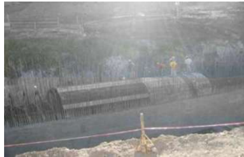
Imágenes del cimbrado y armado del arco de la bóveda
