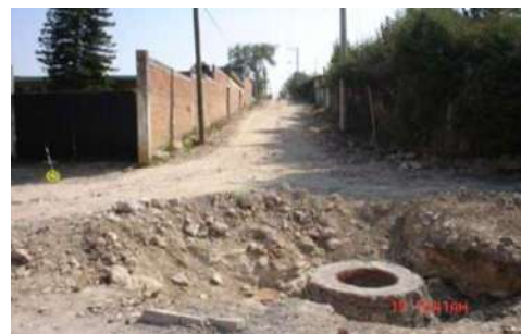
Estado original de la calle antes de iniciar los trabajos de pavimentación
