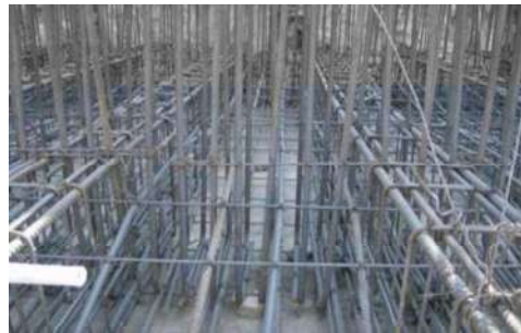
Vista del armado en trabes y cimentación
