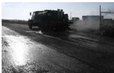
Riego de impregnación con emulsión asfáltica en capa de base
