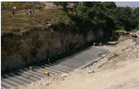
Vista del armado parcial de las contratraves
