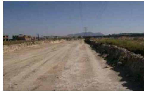
Vista del terreno con corte en caja
