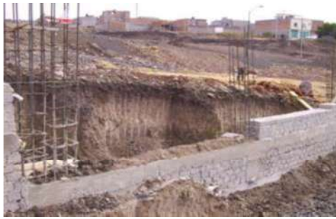
Construcción de muro de contención
