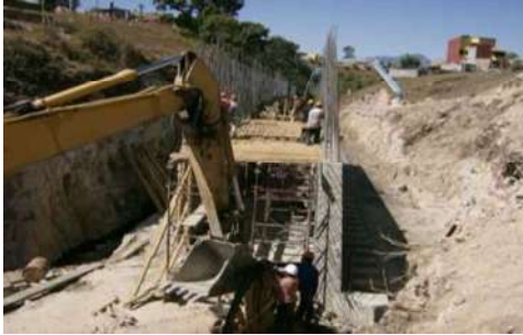
Cimbrado de la arco de bóveda
