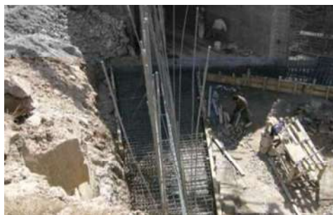
Detalle del armado de zapata y muro de aleros de bóveda
