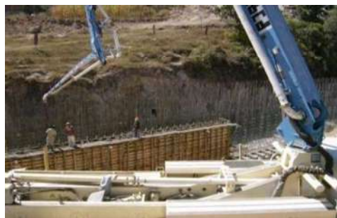
Colado del muro de bóveda con concreto bombeado
