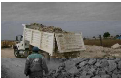
Acarreo de material para capa de filtro
