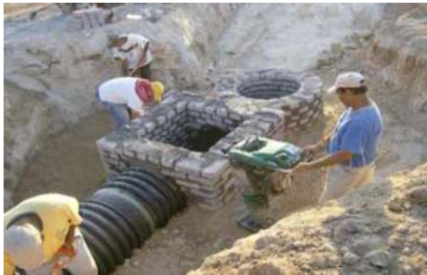
Vista de la construcción de los pozos de visita y cajas de caída adosada
