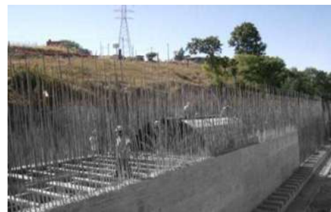
Imagen del muro derecho de la bóveda terminado
