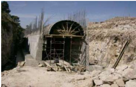
Imágenes del cimbrado y armado del arco de la bóveda
