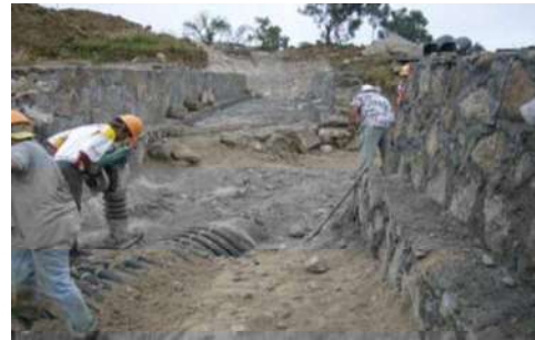
Colocación de tubo de drenaje pluvial bajo paso de alcantarilla
