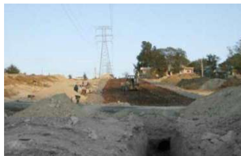
Tendido de la capa de base
