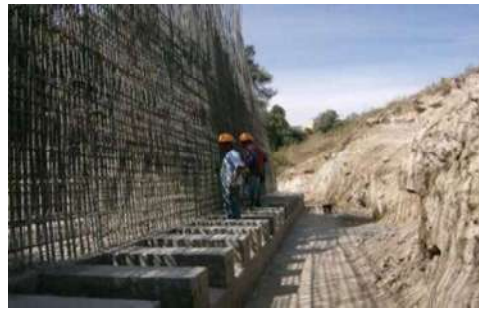
Armado del muro y zapatas de cimentación coladas
