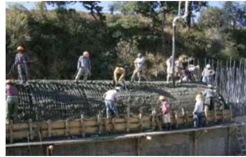
Colado de arco de bóveda con concreto bombeado
