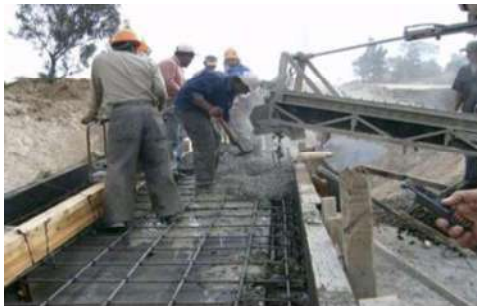
Vista del armado, cimbrado y colado de losa de concreto en paso de alcantarilla
