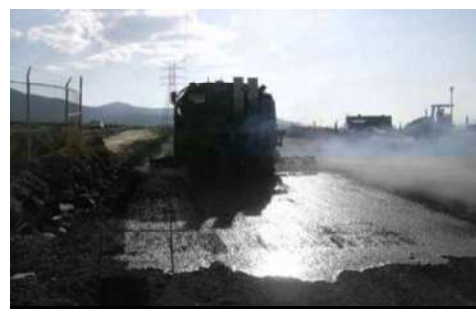
Riego de impregnación con emulsión asfáltica en capa de base
