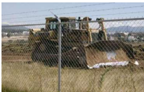
Despalme de terreno con el uso de tractor D8
