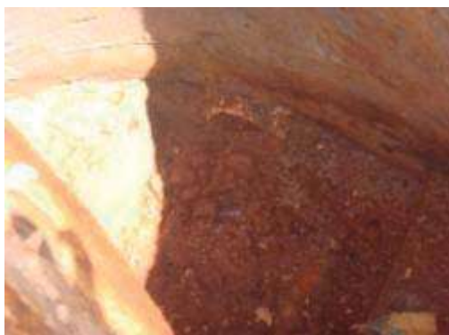
Imagen 18. Alcantarilla de sistema de drenaje.
