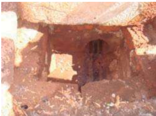
Imagen 17. Alcantarilla del sistema de drenaje.
