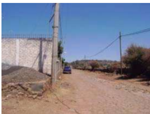
Imagen 25. Cruce en mal estado y sin ningún recubrimiento, entrada a la localidad de la Noria.
