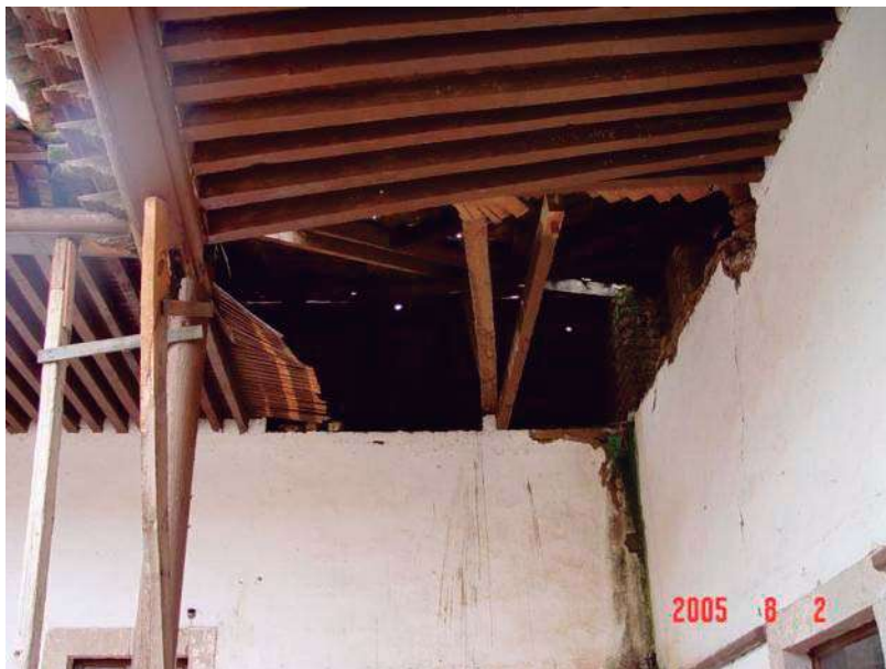
Apuntalamientos preventivos en mal estado, sin forma en las gualdras madera en el portal interior
