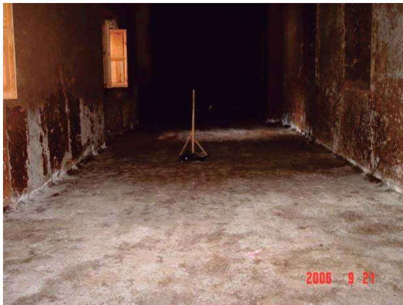
Mejoramiento del terreno con material de tepetate y cal
