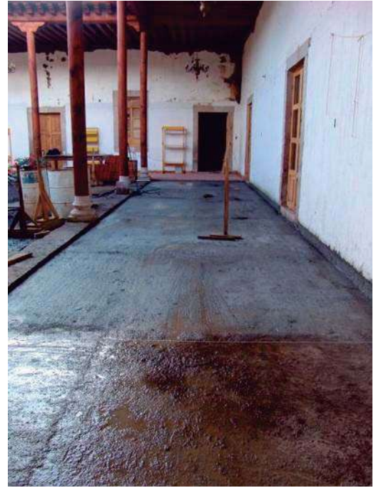
Retiro del piso de mosaico, excavación, mejoramiento del terreno y la colocación del firme de concreto
