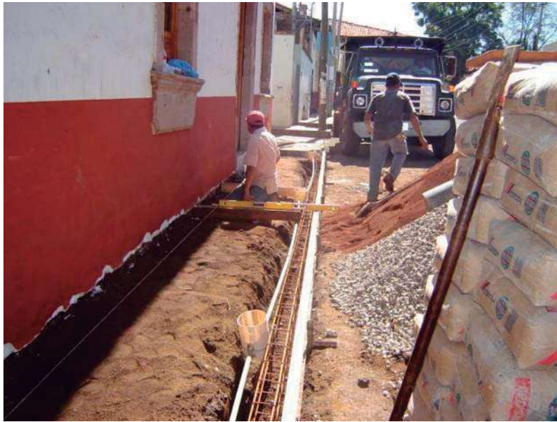
Mejoramiento del terreno de la banqueta y armado de la guarnición para recibir el firme
