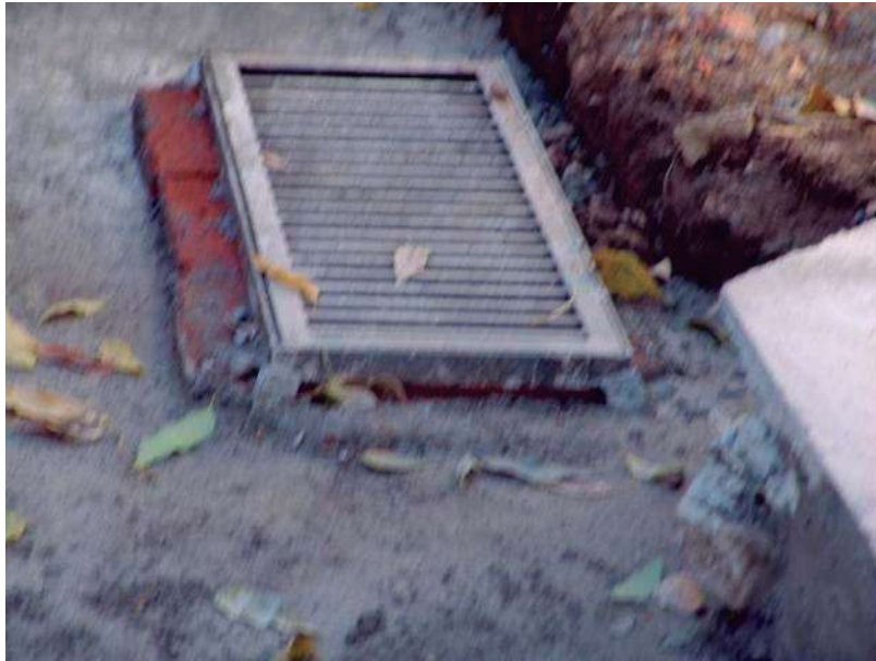
Integración de una coladera de herrería en el patio exterior
