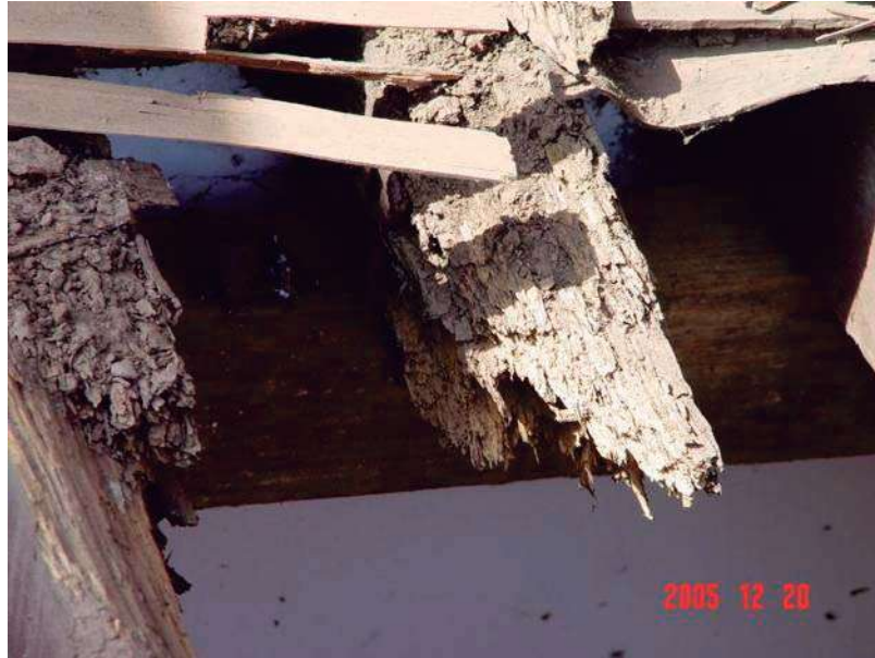
Vigas en mal estado con su tapa de tejamanil
