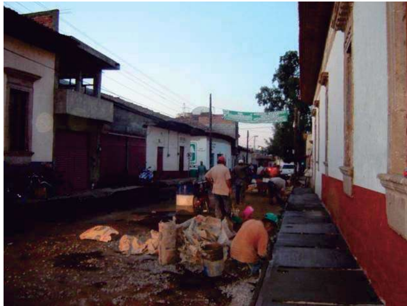
Mejoramiento del terreno de la banqueta y armado de la guarnición para recibir el firme
