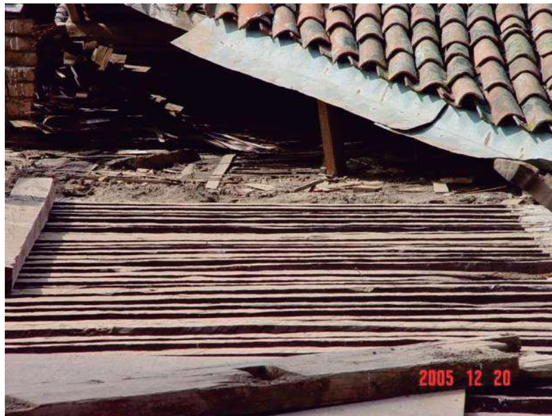
Vigas en mal estado con su tapa de tejamanil
