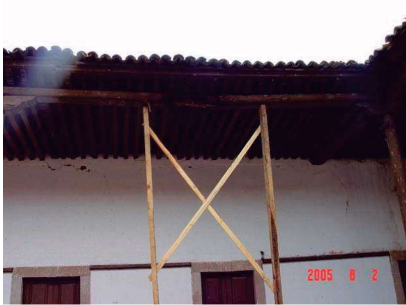
Apuntalamientos preventivos en mal estado, sin forma en las gualdras madera en el portal interior
