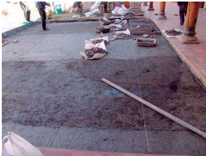
Se integro el firme de concreto en el patio exterior
