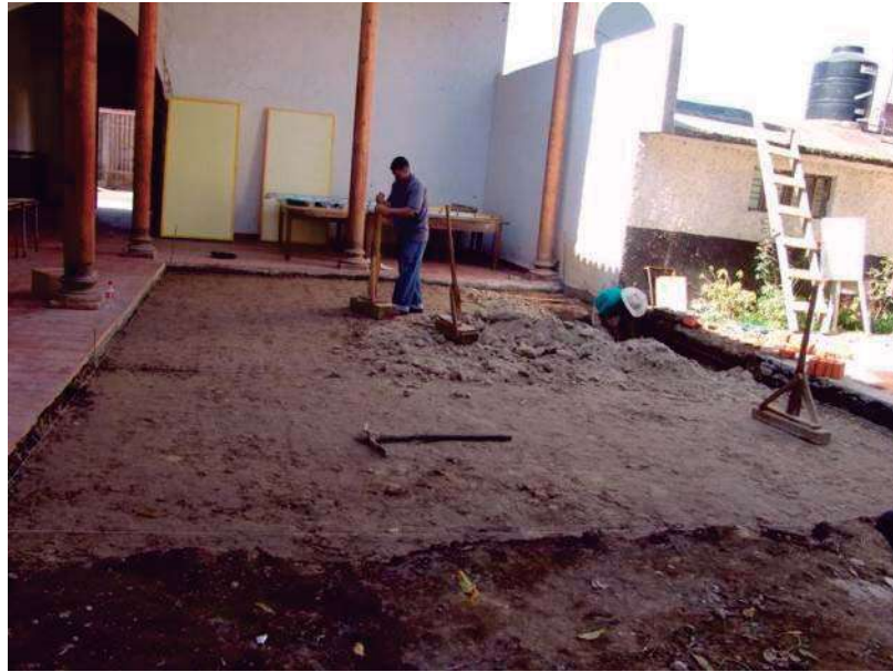
Apisonamiento del terreno en el patio exterior de la excasa, a base de tepetate
