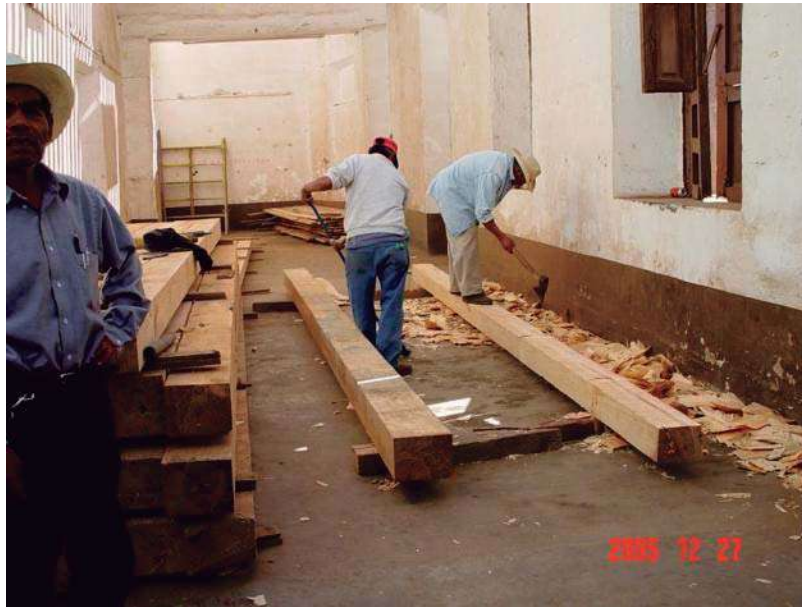
Hacheado de la vigas de madera
