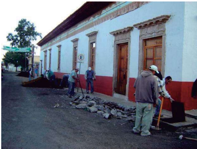
Vista de la demolición de la banqueta de concreto que se encontraba en mal estado
