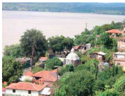
78_IMAGEN_Vivienda Típica con Cubiertas a 4 Aguas_ Fotografía: Ana L. Fuentes
