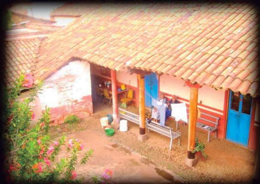
Imagen # 23: Corredor de la vivienda de Don Leopoldo Lázaro Madrigal en Av. Francisco I. Madero # 45 en San Jerónimo Purenchécuaro, FUENTE: Alelí Cortés Vargas. (Septiembre 2008)
