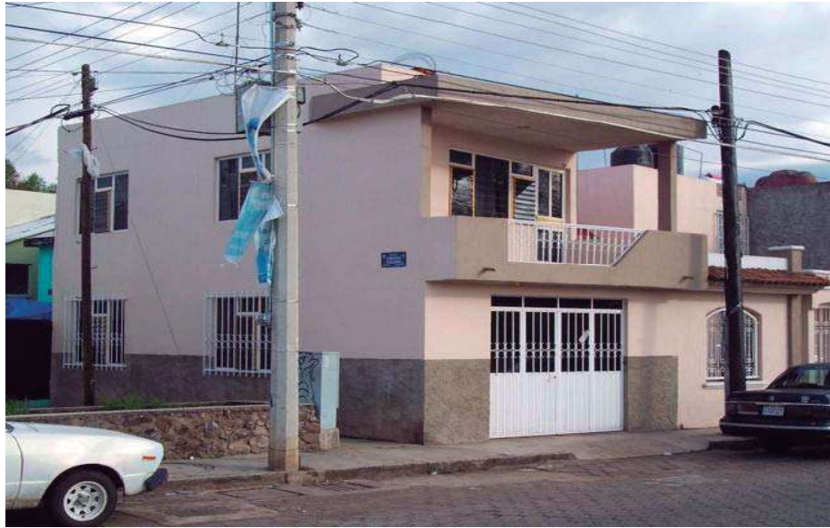
IMAGEN 12 SERVICIOS DE ENERGIA ELECTRICA Y TELEFONIA
