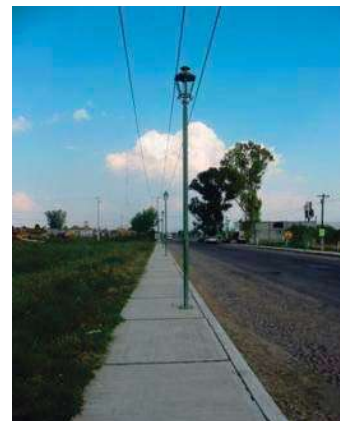
054.- Electrificación en la avenida principal Fotografía: Alejandro Alcántara Catarino.
