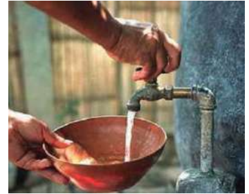
AGUA POTABLE; IMAGEN 078
