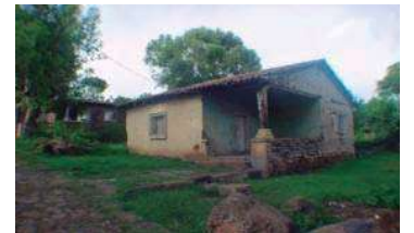
VIVIENDA CATALOGADA; IMAGEN 071
