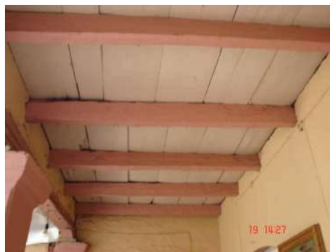
Imagen 39 y 40. Ejemplo de tapa de tablón en Túnguitiro y Jiquilpan Michoacán. Fuente: fotografías tomada por el autor para el proyecto “Revaloración del patrimonio cultural edificado como elemento de identidad en las comunidades rurales del Estado de Michoacán”.
