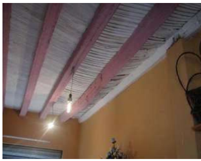
Imagen 41, 42 y 43. Ejemplo de tapa de tejamanil en Ixtlán, Terejero y Numarán Michoacán. Fuente: fotografías tomada por el autor para el proyecto “Revaloración del patrimonio cultural edificado como elemento de identidad en las comunidades rurales del Estado de Michoacán”.
