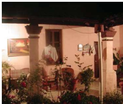
Imagen 34 y 35. Pilares de mampostería. Fuente: fotografías tomada por el autor para el proyecto “Revaloración del patrimonio cultural edificado como elemento de identidad en las comunidades rurales del Estado de Michoacán”.
