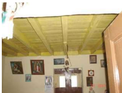
Imagen 36, 37 y 38. Viguerías de tapanco en Pajacuaran, Terejero y Purepero Michoacán. Fuente: fotografías tomada por el autor para el proyecto “Revaloración del patrimonio cultural edificado como elemento de identidad en las comunidades rurales del Estado de Michoacán”.
