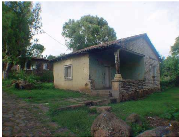
Imagen 1. Ejemplo de Arquitectura Rural en Michoacán. Fuente: fotografía tomada para el proyecto “Revaloración del patrimonio cultural edificado como elemento de identidad en las comunidades rurales del Estado de Michoacán”.
