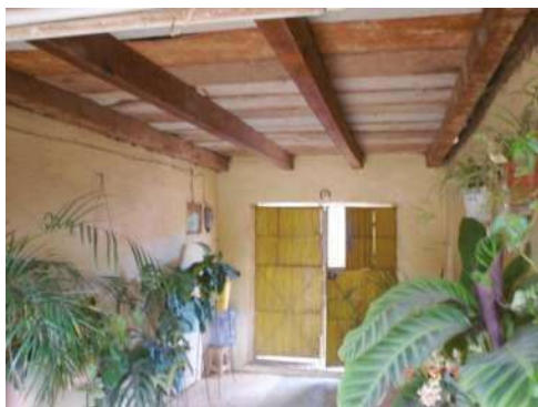
Imagen 39 y 40. Ejemplo de tapa de tablón en Túnguitiro y Jiquilpan Michoacán. Fuente: fotografías tomada por el autor para el proyecto “Revaloración del patrimonio cultural edificado como elemento de identidad en las comunidades rurales del Estado de Michoacán”.
