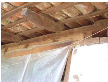
Imagen 48, 49 y 50. Utilización de fajillas en Terejero, Michoacán. Fuente: fotografías tomada por el autor para el proyecto “Revaloración del patrimonio cultural edificado como elemento de identidad en las comunidades rurales del Estado de Michoacán”.
