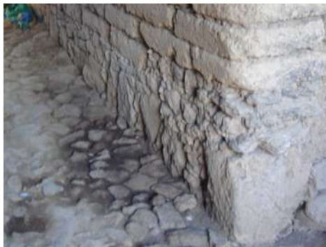
Imagen 23 y 24. Aplicación de la piedra braza como sobrecimiento y piso.
