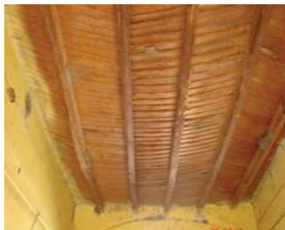
Imagen 41, 42 y 43. Ejemplo de tapa de tejamanil en Ixtlán, Terejero y Numarán Michoacán. Fuente: fotografías tomada por el autor para el proyecto “Revaloración del patrimonio cultural edificado como elemento de identidad en las comunidades rurales del Estado de Michoacán”.
