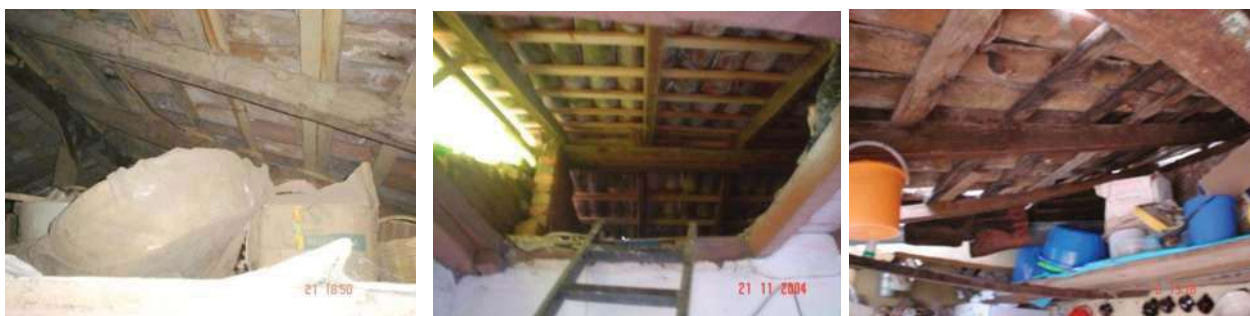
Imagen 44, 45 y 46. Ejemplo de vigas larguero en Purepero y Tunguitiro Michoacán. Fuente: fotografías tomada por el autor para el proyecto “Revaloración del patrimonio cultural edificado como elemento de identidad en las comunidades rurales del Estado de Michoacán”.
