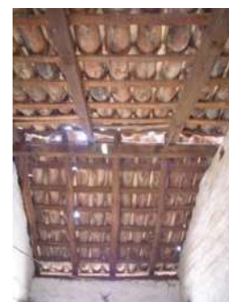
Imagen 48, 49 y 50. Utilización de fajillas en Terejero, Michoacán. Fuente: fotografías tomada por el autor para el proyecto “Revaloración del patrimonio cultural edificado como elemento de identidad en las comunidades rurales del Estado de Michoacán”.
