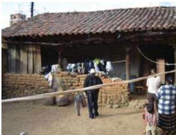
Imagen 51, 52 y 53. Cubiertas de teja de barro rojo recocido en Santiago asajo y Pajacuaran Michoacán. Fuente: fotografías tomada por el autor para el proyecto “Revaloración del patrimonio cultural edificado como elemento de identidad en las comunidades rurales del Estado de Michoacán”.
