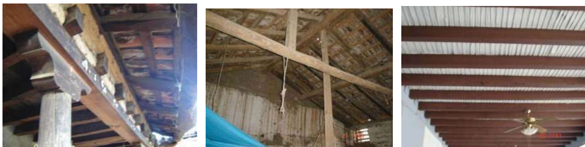
Imagen 18, 19 y 20. Aplicación de la madera en la elaboración de zapatas, vigas larguero y vigería de tapanco. Fuente: fotografías tomada por el autor para el proyecto “Revaloración del patrimonio cultural edificado como elemento de identidad en las comunidades rurales del Estado de Michoacán”.
