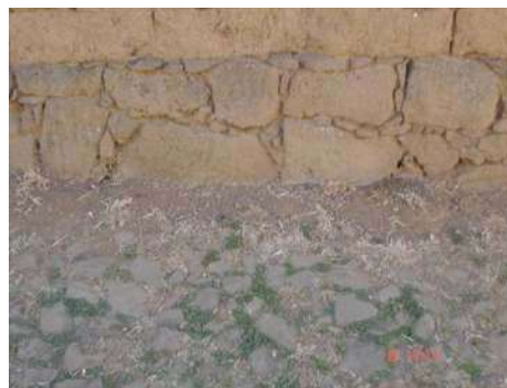
Imagen 23 y 24. Aplicación de la piedra braza como sobrecimiento y piso.
