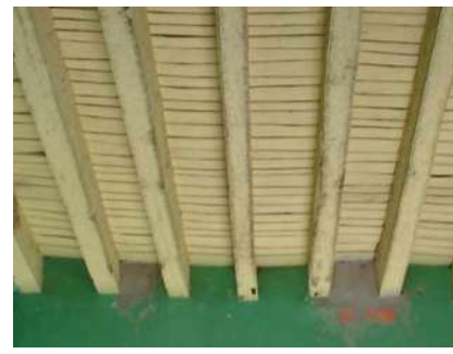
Imagen 41, 42 y 43. Ejemplo de tapa de tejamanil en Ixtlán, Terejero y Numarán Michoacán. Fuente: fotografías tomada por el autor para el proyecto “Revaloración del patrimonio cultural edificado como elemento de identidad en las comunidades rurales del Estado de Michoacán”.
