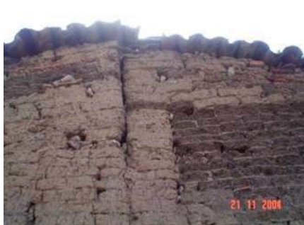
Imagen 21 y 22. Utilización de la arcilla para la elaboración de adobe. Fuente: fotografías tomada por el autor para el proyecto “Revaloración del patrimonio cultural edificado como elemento de identidad en las comunidades rurales del Estado de Michoacán”.
