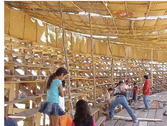
IMAGEN DEL COLOCADO DE OTATES Y TABLONES
