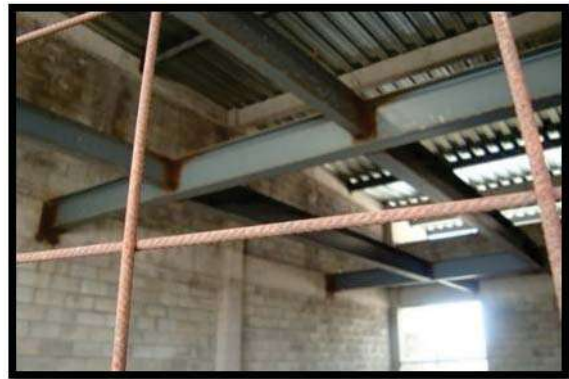
Foto3. Tomada el 5 de Marzo del 2010 en la central de abasto Toluca, fuente (R.H.JR) En la fotografía se observa la estructura la cual se utilizara y la ventilación del mezanine, para que se ventilen los productos.
