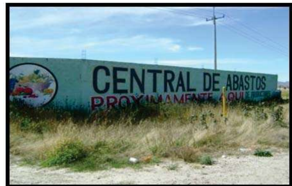
Foto 10. Tomada el 26 de Enero del 2010, en el terreno propuesto para la central de abasto, por (R.H.JR.) el cual nos sirve para ver que cuenta el terreno con electrificación.
