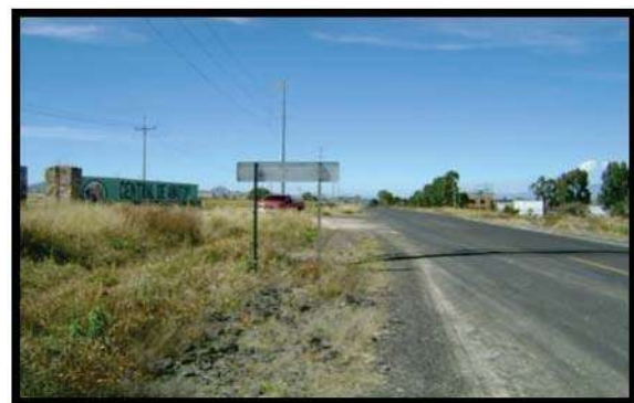
Foto 11.- Tomada el 26 de Enero del 2010. Del terreno, sobre la carretera Maravatío Acambaro, por (R.H.JR.) Se aprecia claramente una vía pavimentada al costado del terreno Maravatío Acambaro Gto.
