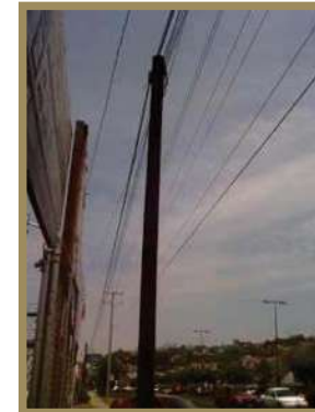
Fig. 80 Algunos servicios con que cuenta el terreno, poste de teléfono.
