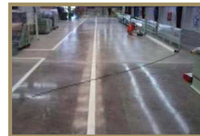
Fig. 93 Piso de concreto pulido.
