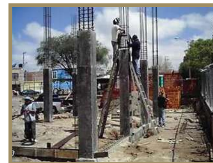
Fig. 91 Columnas de concreto.
