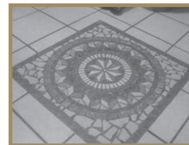
Fig. 94 Colocaciones de Vitropiso.
