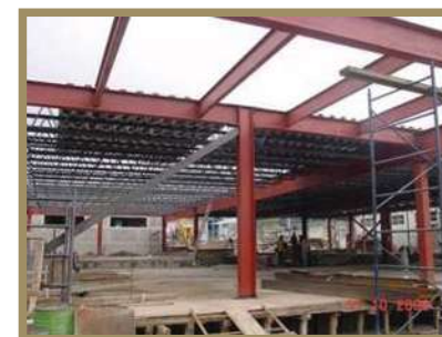
Fig. 90 Columnas metálicas.
