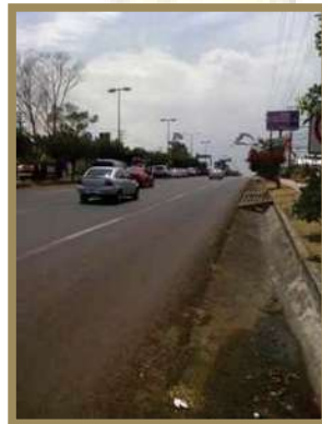
Fig. 78 Libramiento Sur, sobre el cual se ubica el terreno.
