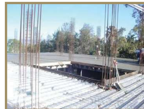
Fig. 92 Armado y colado de losa de entrepiso.
