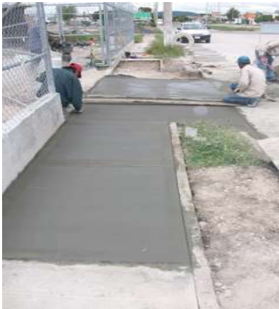
Banqueta de concreto simple F_c = 150 \text{ kg/cm}^2 , espesor de 10 cms. Incluye: mano de obra y todos los materiales necesarios para su elaboración.
