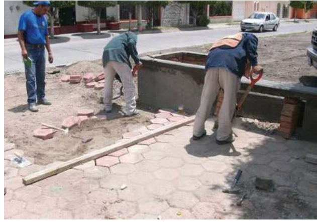
SUMINISTRO Y COLOCACIÓN DE PAVIMENTO A BASE DE ADOQUIN HEXAGONAL DE 20.0 CMS. DE DIÁMETRO
