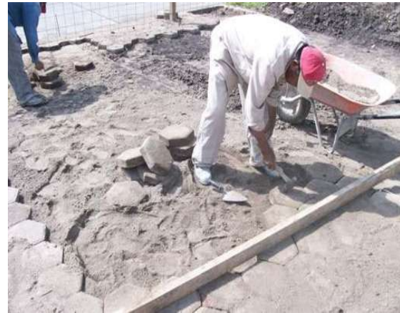
Colocación de pavimento a base de adoquín asentado sobre base de arena de 10 cms. de espesor; incluye mano de obra y todos los materiales necesarios para su correcta ejecución.
