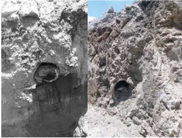
TAPONEO DE LINEA EXISTENTE FUERA DE SERVICIO DE 18"
