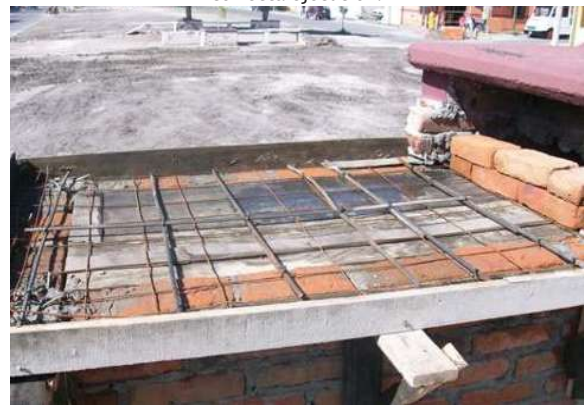
Losa de concreto armado de F_c = 200 \text{ kg/cm.} , t.m.a. \frac{3}{4} , espesor de 7 cm., reforzada con malla electro soldada 6 \times 6 - 10 / 10 . Incluye: acarreo, cimbra, descimbra, vaciado, vibrado y curado."
