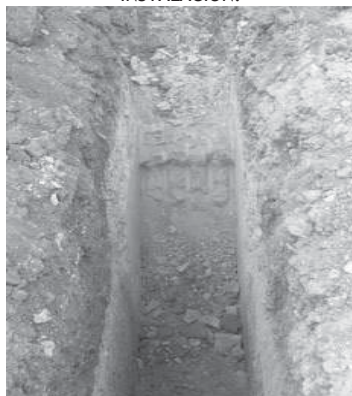
EXCAVACION CON MÁQUINA PARA ZANJAS EN MATERIAL TIPO II A EN SECO. INCLUYE: AFLOJE, EXTRACCIÓN DEL MATERIAL, AFINE DE TALUDES, FONDO Y CONSERVACIÓN HASTA LA INSTALACIÓN DE LA TUBERÍA A UNA PROFUNDIDAD DE 2.00 A 4.00 METROS.
