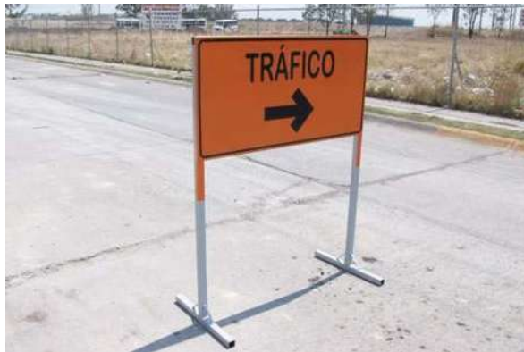
Suministro y colocación de letrero de desvío de tráfico de 0.60x1.20 m, con bastidor de ángulo y tablero de lámina lisa calibre 16 pintura esmalte, rotulado de acuerdo al modelo proporcionado por la CEAG.
