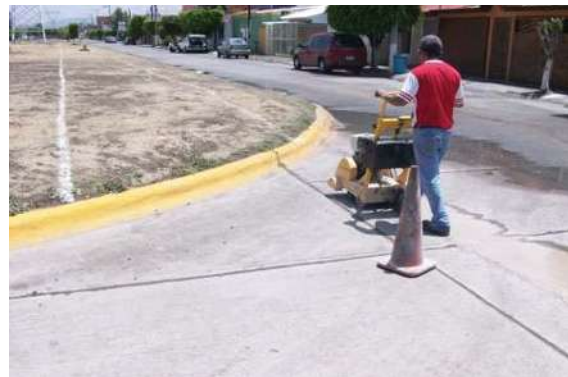
Corte de pavimento de concreto hidráulico con cortadora de gasolina y disco con puntas de diamante de 18 HP (5 cm de profundidad).
