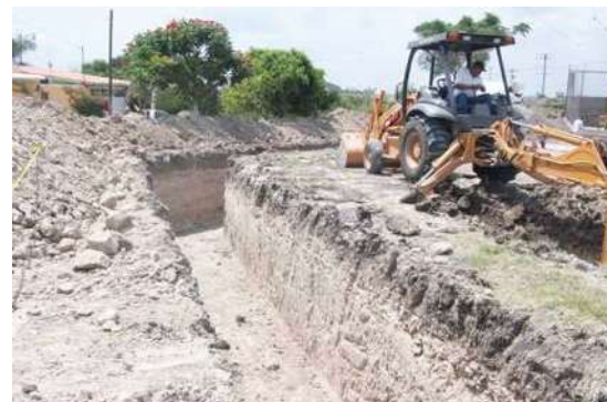
EXCAVACION CON MÁQUINA PARA ZANJAS EN MATERIAL TIPO II A EN SECO. INCLUYE: AFLOJE, EXTRACCIÓN DEL MATERIAL, AFINE DE TALUDES, FONDO Y CONSERVACIÓN HASTA LA INSTALACIÓN DE LA TUBERÍA A UNA PROFUNDIDAD DE 0.00 A 2.00 METROS.
