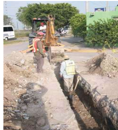
EXCAVACION CON MÁQUINA PARA ZANJAS EN MATERIAL TIPO II A EN SECO. INCLUYE: AFLOJE, EXTRACCIÓN DEL MATERIAL, AFINE DE TALUDES, FONDO Y CONSERVACIÓN HASTA LA INSTALACIÓN DE LA TUBERÍA A UNA PROFUNDIDAD DE 0.00 A 2.00 METROS.
