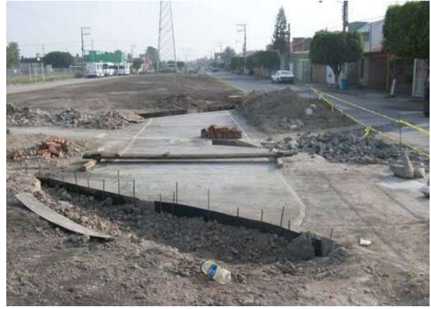
Reposición de pavimento a base de concreto hidráulico de F_c = 250 \text{ Kg/cm}^2 con 20 cm. de espesor.
