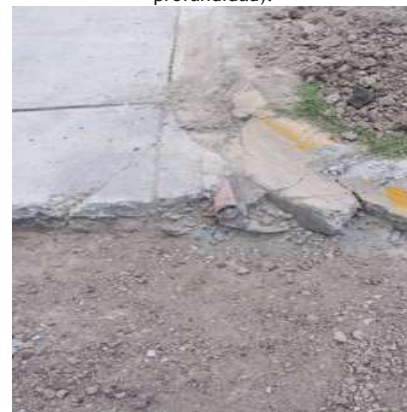
Demolición de guarnición de concreto simple de F_c = 200 \text{ kg/cm}^2 , sección trapezoidal de 15 x 20 x 40 cm. Incluye retiro del material producto de la demolición.
