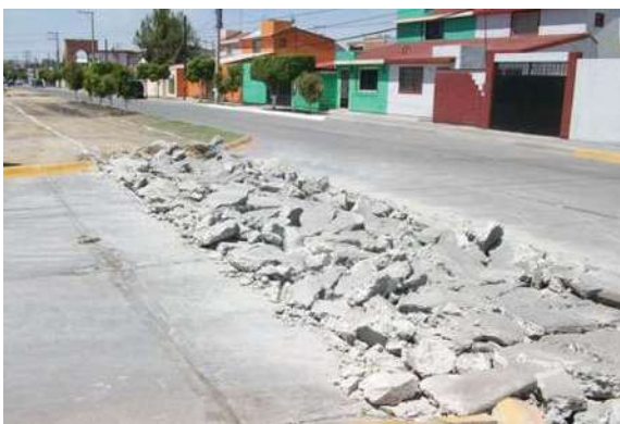
Ruptura con martillo hidráulico de concreto simple de F_c = 250 \text{ kg/cm}^2 en arroyo, espesor de 20 cm. Incluye remoción del material producto de la ruptura.
