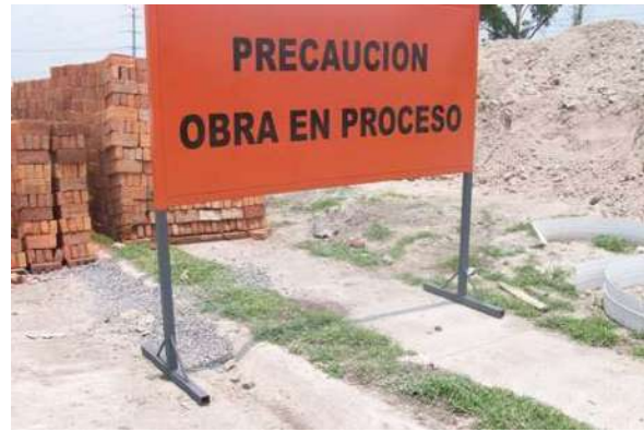
Suministro y colocación de letrero carretero de 1.20 x 2.40 m con bastidor de ángulo y tablero de lámina lisa calibre 16, pintura esmalte, rotulado de acuerdo al logotipo proporcionado por CEAG.
