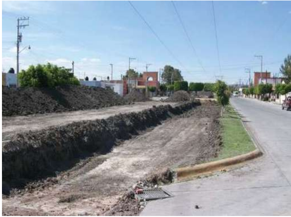
Relleno de zanjas con material producto de la excavación compactado con equipo al 90% prueba proctor, capas de 20 cm. de espesor
