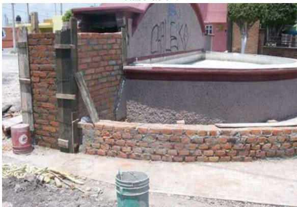
Muro de tabique rojo recocido de 7 \times 14 \times 28 \text{ cm.} en 14 cm. de espesor. Asentado con mortero cemento-arena 1:4.
