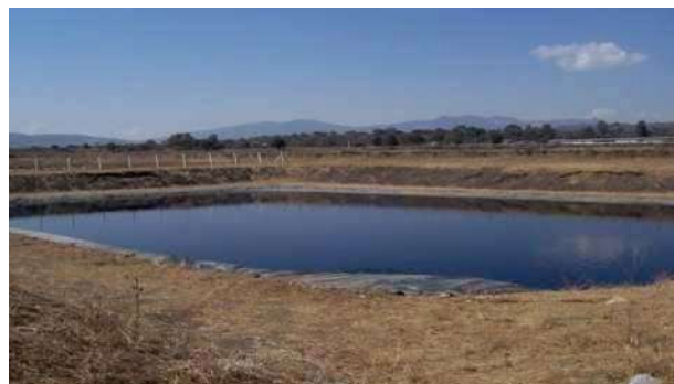
Figura 020. Laguna de lixiviados que captura el líquido de las celdas existentes. Fotografía Violeta Constantino Ortiz 2010
