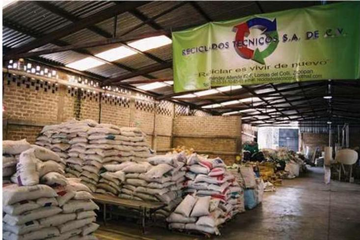
foto -55- Ventilación e iluminación por medio de elementos constructivos (reciclados técnicos s.a. de c.v.)
