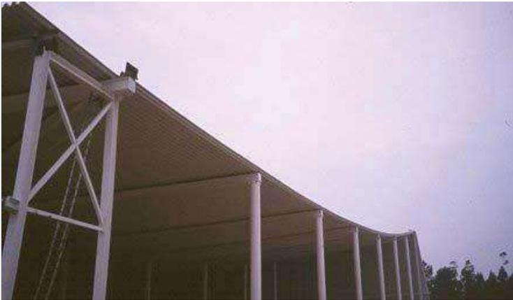
IMAGEN 36. CUBIERTA AUTOPORTANTE DE CURVA
