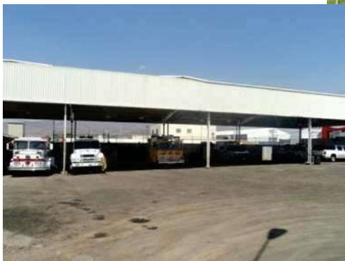
4. Estacionamiento para motobombas
