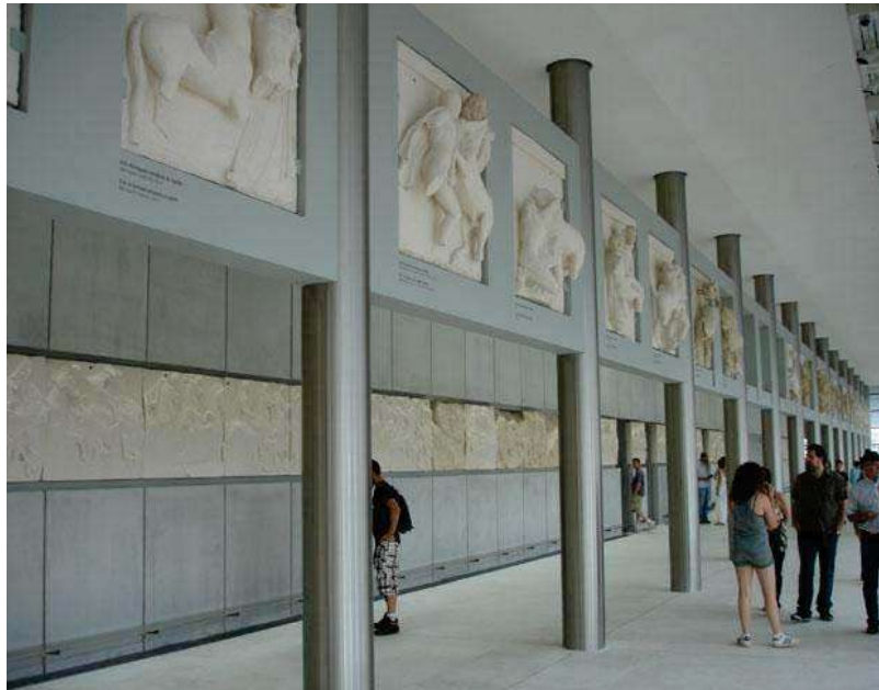
Imagen 32. COLUMNAS DE ACERO. Fuente: Ídem.,.
