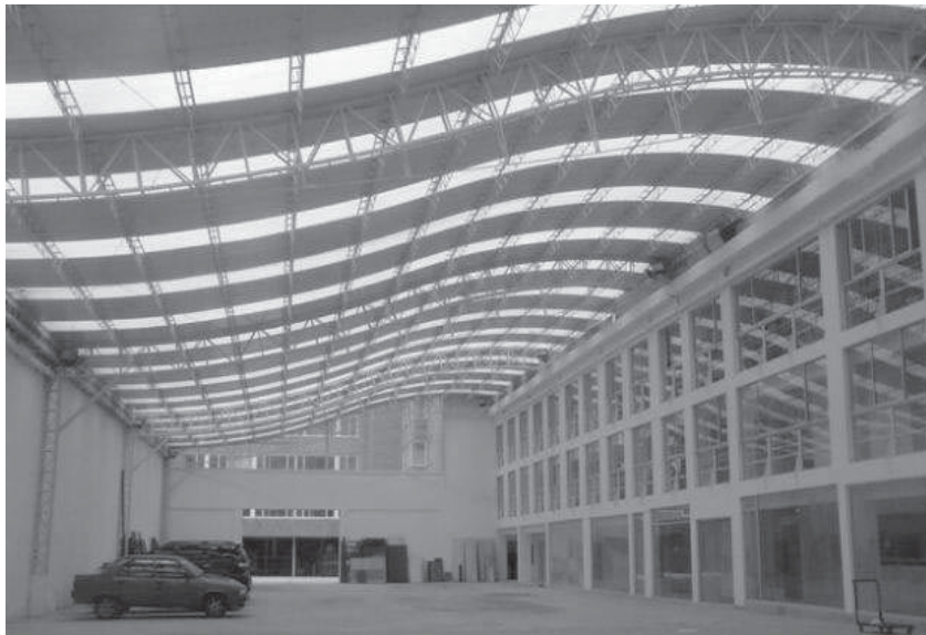
Imagen 35.CUBIERTA DE POLICARBONATO. Fuente: Ídem.,
