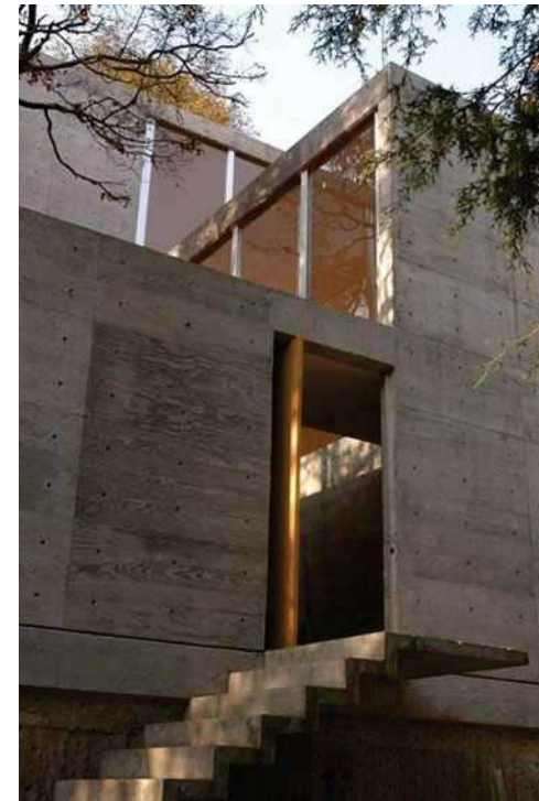
Imagen 39. CONCRETO APARENTE Fuente: Ídem.,
