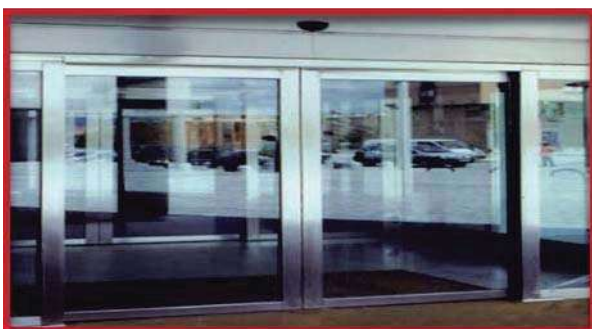
Figura no. 24, Puerta de acceso
