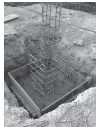
IMAGEN 9 ZAPATA AISLADA
