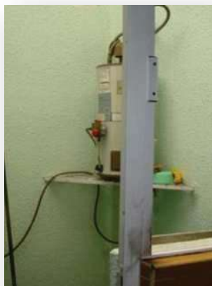
IMAGEN 23 PATIO DE SERVICIO
