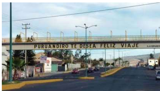
IMAGEN 5 CONSTRUCCION DEL BOULEVARD DE ESTA CIUDAD
