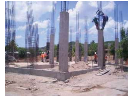
Imagen 15. Columnas de concreto armado, propuestas en el proyecto.
