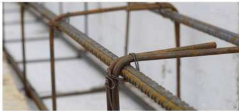
Imagen 14. Castillo, elaborado con varillas de acero, con estribos colocados a una separación según se indique, y amarrados con alambre, similares a los propuestos en el proyecto.
