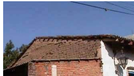
Fig. 10.1.2. Soto Barrera, Karla, Muros de adobe y techumbre a dos aguas.
