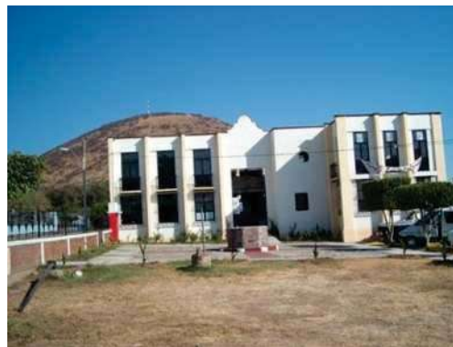
Fig. 3.2.4.- fachada frontal, http://mw2.google.com/mw-panoramio/photos/medium/10366410.jpg , 20 de febrero de 2010.
