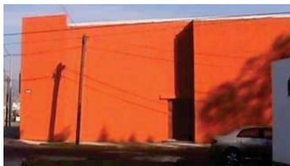
Fig. 3.8.- Soto Barrera, Karla, Fachada este . 15 de noviembre de 2009.
