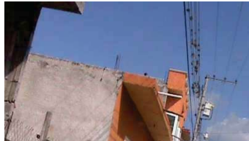
Fig. 6.3.2.1.- Poste de luz, Soto Barrera, Karla, 22 de noviembre de 2009.
