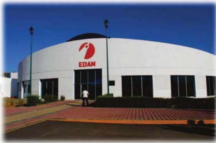
IMAGEN NO.27 FACHADA PRINCIPAL
