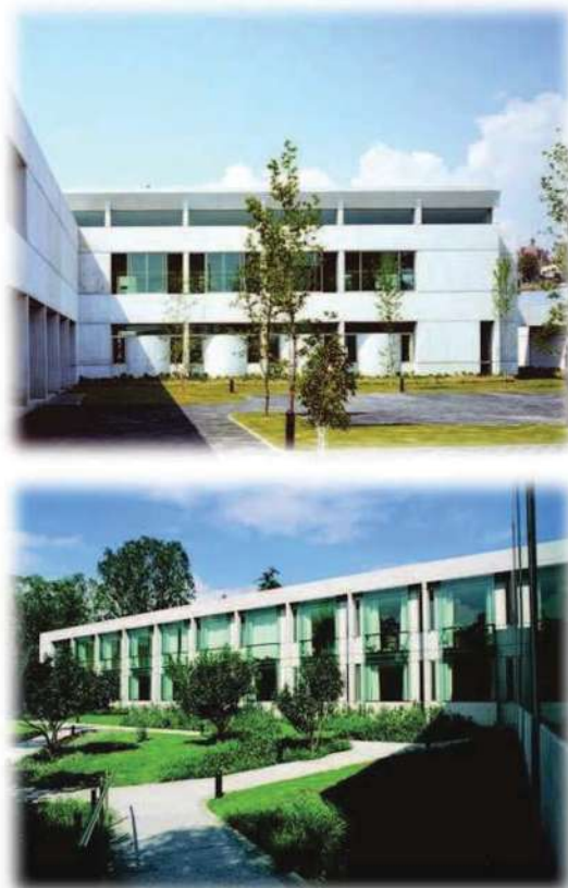
IMAGEN NO. 5 Y 6 FACHADAS
