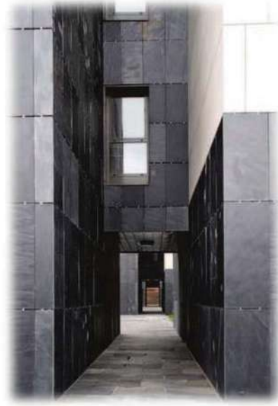
IMAGEN NO.26 PASILLOS EXTERIORES
