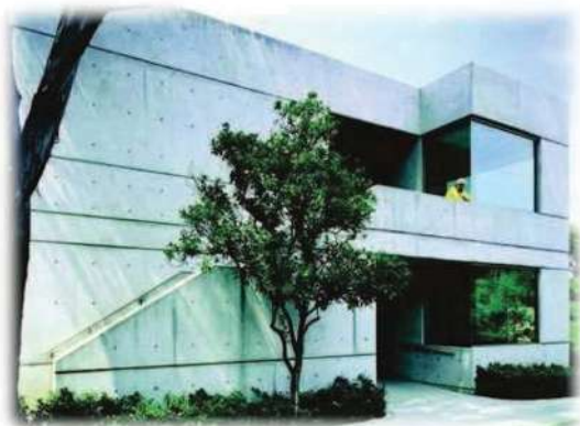
IMAGEN NO.8 FACHADA EXTERIOR
