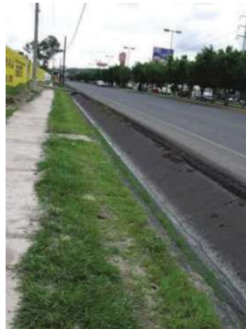
FOTO 6: BANQUETA Y CANAL DE AGUA PLUVIAL
