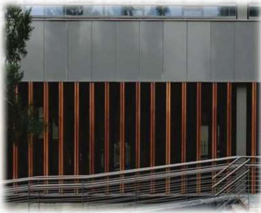
IMAGEN NO. 17 FACHADA PRINCIPAL
