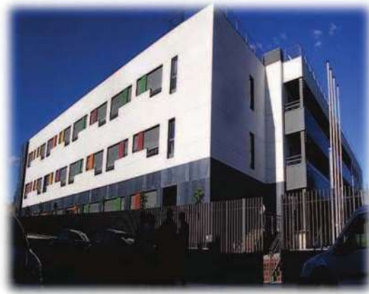
IMAGEN NO. 18 FACHADA DESDE LA CALLE
