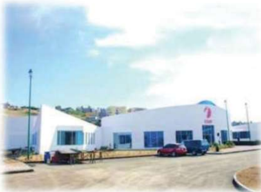
IMAGEN NO. 31 FACHADA PRINCIPAL
