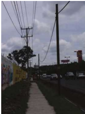
FOTO 5: POSTES DE ALTA Y BAJA TENSIÓN
