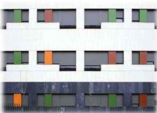
IMAGEN NO. 19 FACHADA DE LAS HABITACIONES
