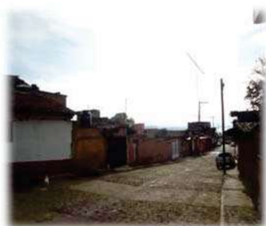
Ilustración 43, cableado de teléfono, CMJ, abril 2011
