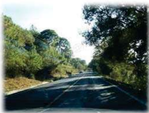
Ilustración 38, carretera Quiroga Morelia
