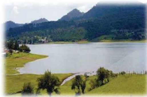
Imagen 1.3 Http. Google imágenes/presa Pucuito/Cd. Hidalgo/23-Dic-2010.
