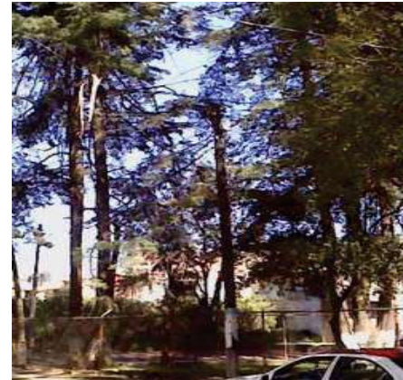
FOTO 15: Vista de los postes que abastecen el servicio de cable y teléfono
