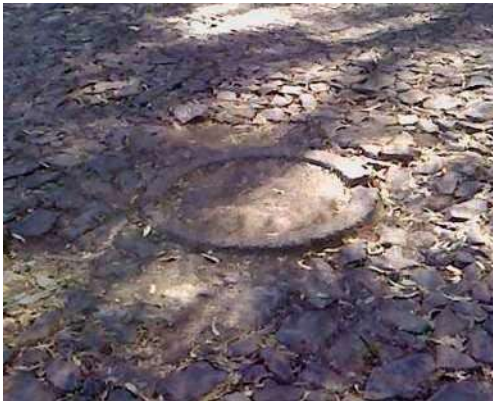
FOTO 16: Vista del pozo de visita del servicio de drenaje
