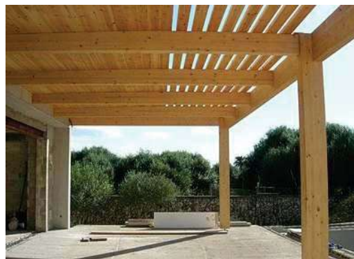
IMAGEN 10: Pórtico a base de columnas y vigas de madera.
