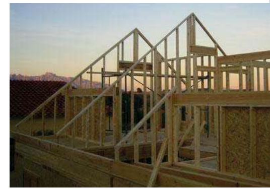
IMAGEN 11: Estructura de madera la cual soporta el peso de la cubierta.
