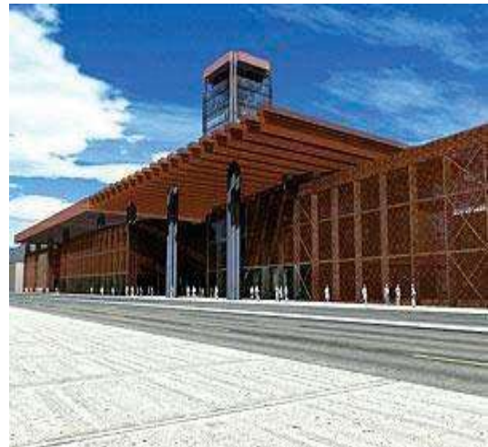
FACHADA CON ACERO CORTEN
