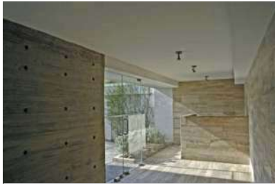
Muro interior a base de concreto
