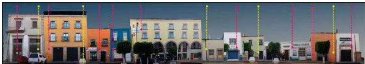
Calle Eduardo Ruíz. Contexto de la Fototeca. Situación actual.
