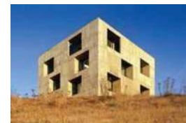
Concreto. Exterior Casa Poli
