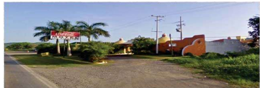
F30>vista este del terreno.
