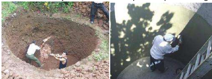
Fig.114 Elaboración de aljibe de ferrocemento para la captación de agua pluvial
