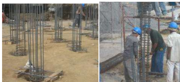
Fig.30 Pilotes (Armaduría colocada en las perforaciones. Colocación de la estructura)
