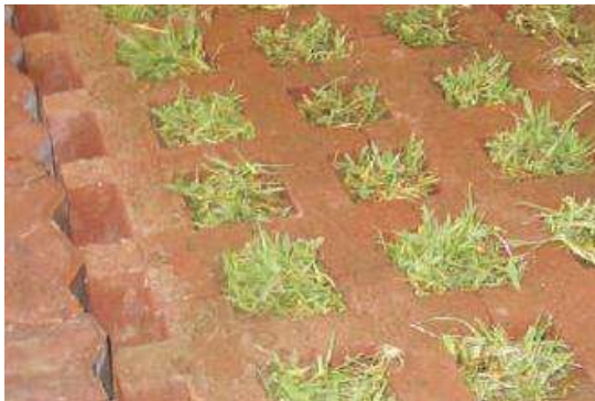
Fig. 79.-Colocación de súper adopasto
