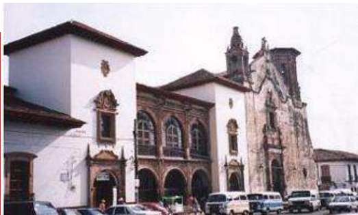
Figura 28. Teatro Emperador Caltzontzin. http://www.patzcuaro-web.com/03/03cute01.htm
