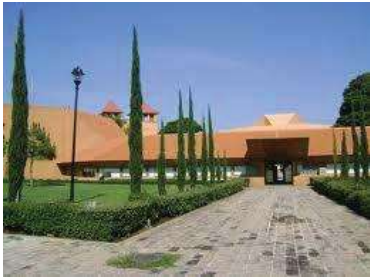
Figura 73. Acceso Centro de Convenciones. MGDC.
