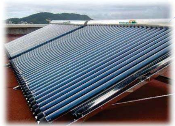
Arreglo solar hidráulico. Imagen 44
