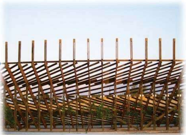
Preparado del soporte de la pista. Foto 75
