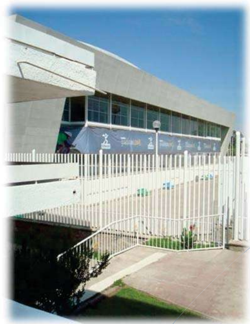
Foto en Vista lateral de la Obra. Foto 33
