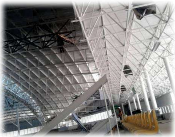
Armadura de Cubierta principal. Foto 37
