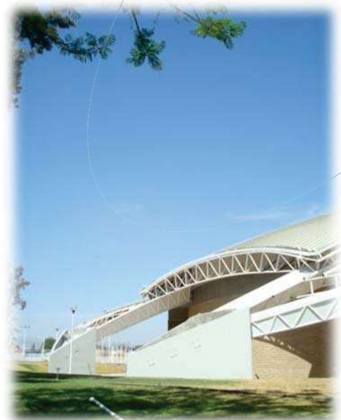
Vista de los soportes de la cubierta del velódromo. Foto 34
