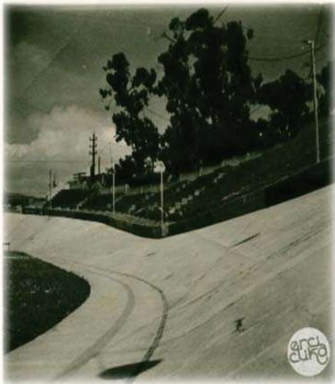
Pista de rodamiento de concreto 1894. Imagen 18
