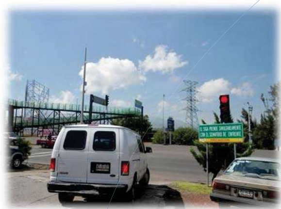
Puente peatonal, Señalización y semáforos. Foto 59
