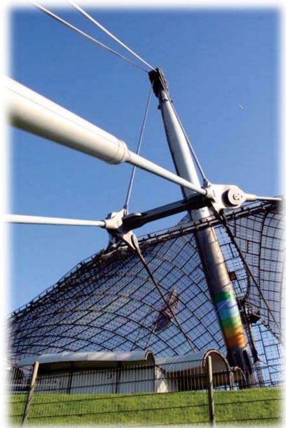
Foto de Tensores y armadura de cubierta. Foto 31
