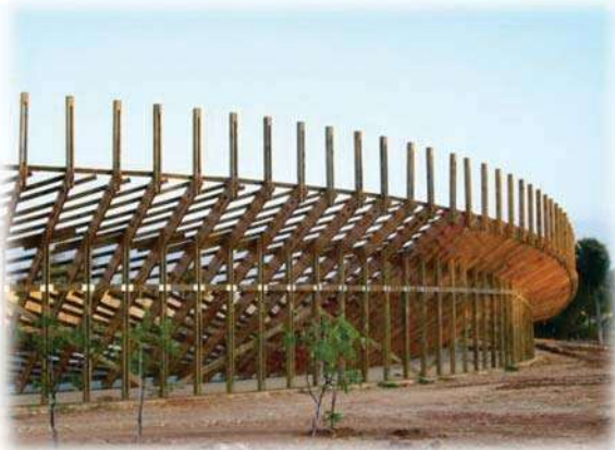
Armado y levantamiento de pista de rodamiento. Foto 74 xiv
