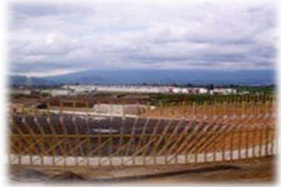
Vista aérea del soporte de la pista. Foto 76
