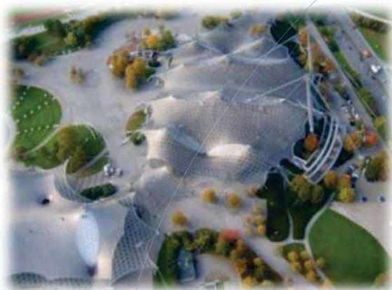
Vista Aérea de cubierta. Imagen 27
