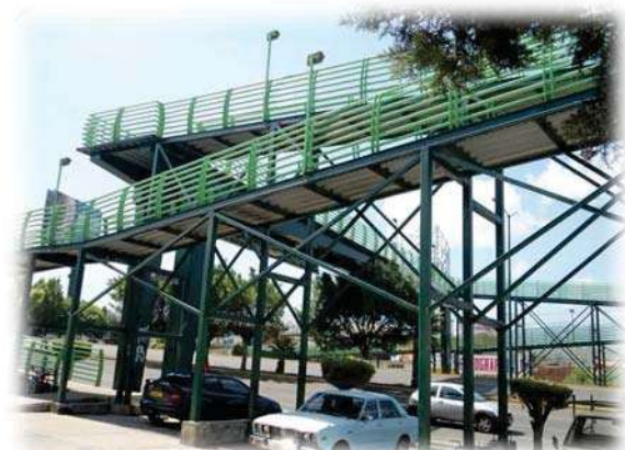
Puente Peatonal periférico independencia COTSCO. Foto
