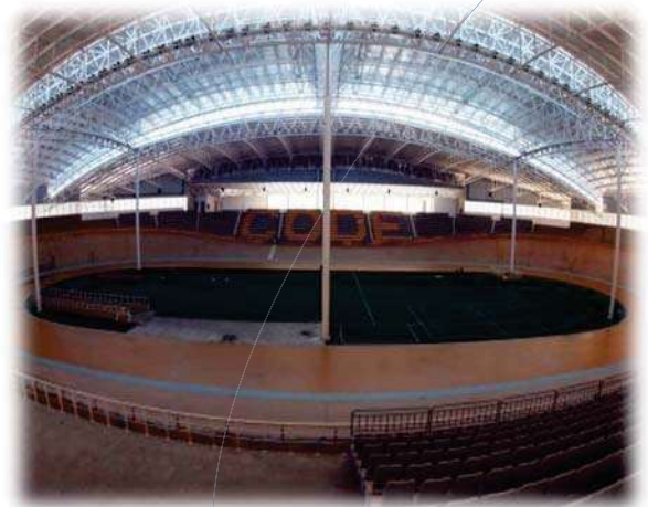
Pista, Armadura y Estructura de la nave del Velódromo. Foto 39
