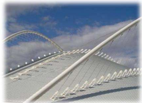
Vista del exterior de tensores de cubierta. Imagen 25
