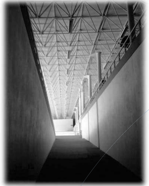
Rampa de acceso, estructura ligera. Foto 36
