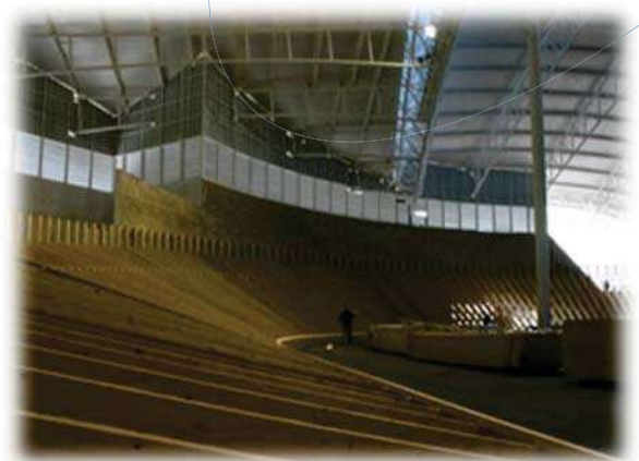
Estructura de la Pista. Foto 73 Armadura y levantamiento de pista
