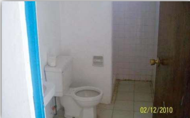
INTERIORES ANTES DE LA OBRA
