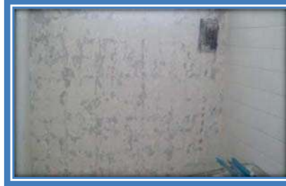
DEMOLICION EN MUROS DE AZULEJO
