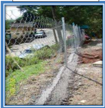
COLOCACION MALLA CICLONICA
