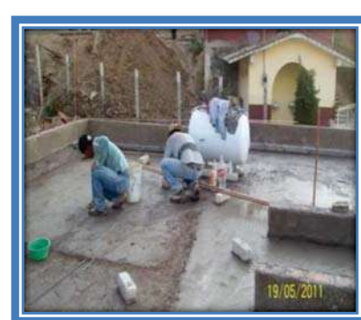
ENTORTADO EN LOSA
