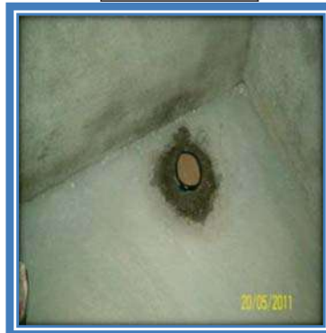
COLADERA EN BAÑO
