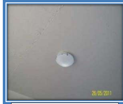
COLOCACION DE LAMPARAS
