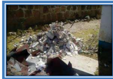
ESCOMBRO DE DEMOLICIONES
