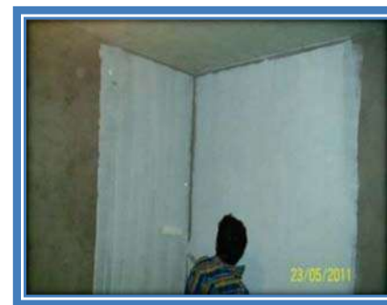
PINTURA EN MUROS
