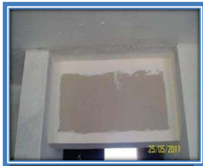
COLOCACION DE ANTEPECHOS DE TABLA ROCA
