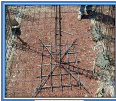
ACERO PARA ZAPATAS
