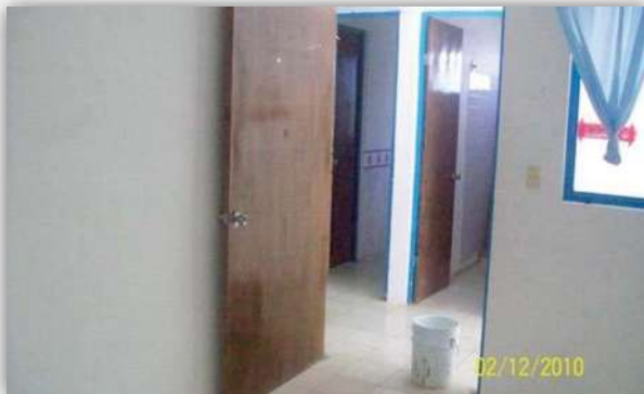
INTERIORES ANTES DE LA OBRA
