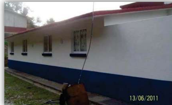
FACHADA POSTERIOR OBRA TERMINADA
