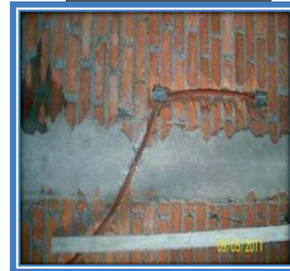
SALIDAS PARA CONTACTO O APAGADOR
