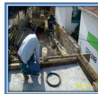
CIMBRA EN TRABES
