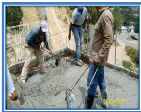
CONCRETO EN LOSA
