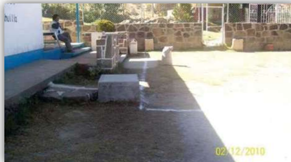
VISTA GENERAL ANTES DE LA OBRA
