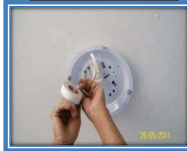
COLOCACION DE LAMPARAS
