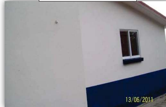
FACHADA LATERAL DESPUES DE LA OBRA
