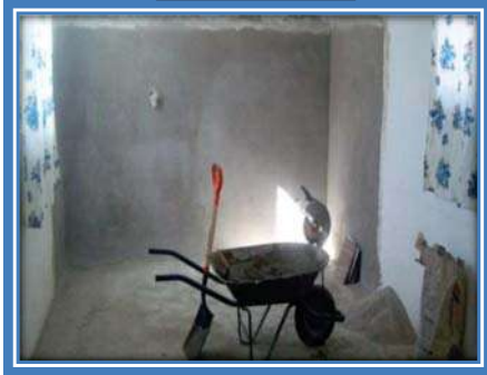
APLANADO EN MUROS
