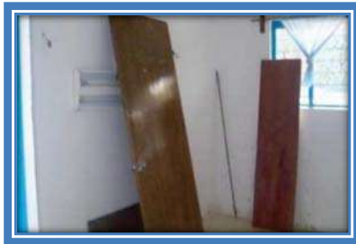
DESMONTAJE DE PUERTAS
