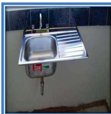
COLOCACION DE TARJA
