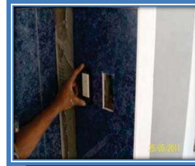
COLOCACION DE CONTACTOS Y APAGADORES
