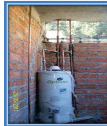
SALIDAS DE GAS PARA CALENTADOR DE AGUA
