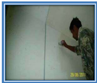
PINTURA EN MUROS
