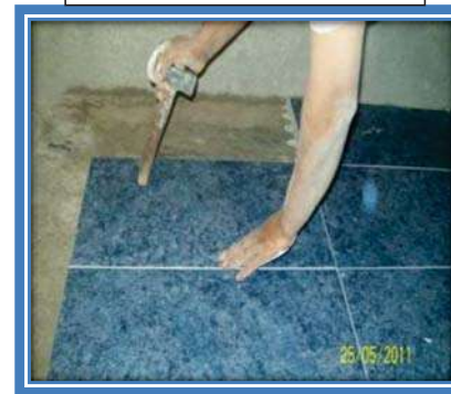
COLOCACION DE AZULEJO EN BAÑOS Y COCINA
