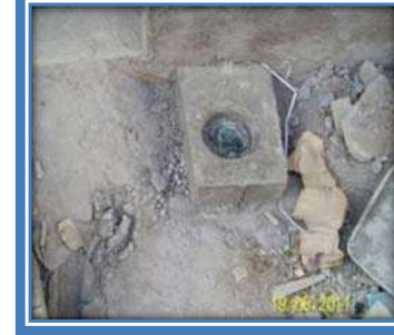
COLOCACION DE VARILLA COOPERWELD
