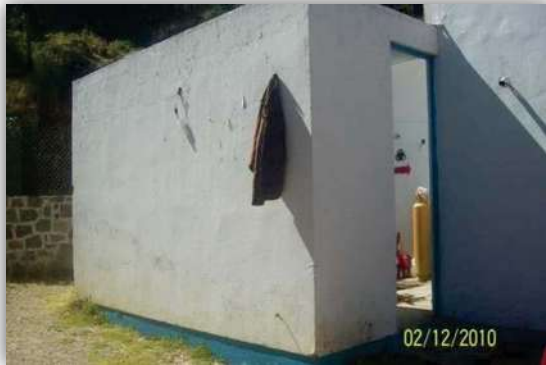
FACHADA LATERAL ANTES DE LA OBRA
