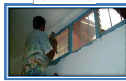
DESMONTAJE DE VENTANAS
