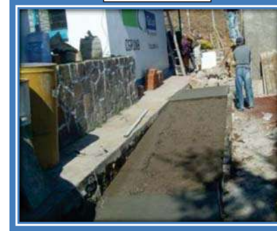
RAMPA DE ACCESO
