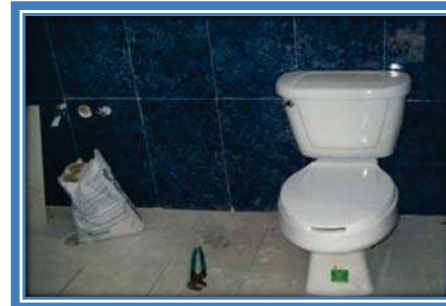
COLOCACION DE INODORO
