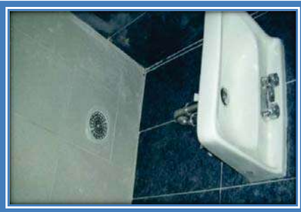
COLOCACION DE LAVABO Y COLADERA
