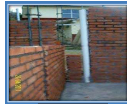
BAJADA DE AGUA PARA LOSA
