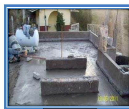
ENTORTADO EN LOSA
