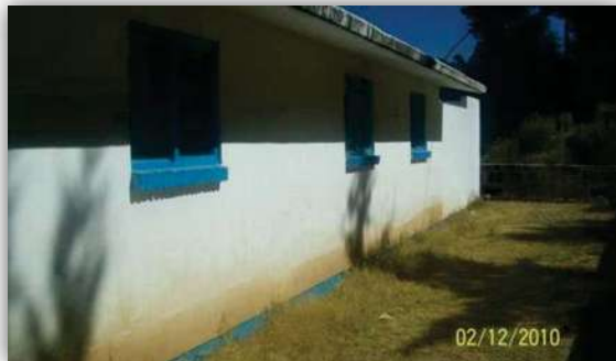
FACHADA POSTERIOR ANTES DE LA OBRA
