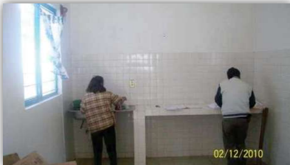
INTERIORES ANTES DE LA OBRA
