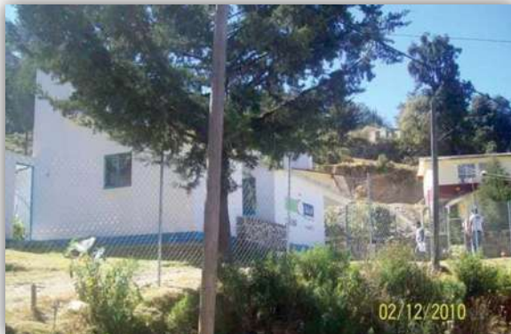
VISTA GENERAL ANTES DE LA OBRA
