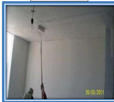
PINTURA EN PLAFONES
