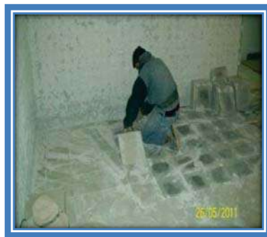
COLOCACION DE PISO
