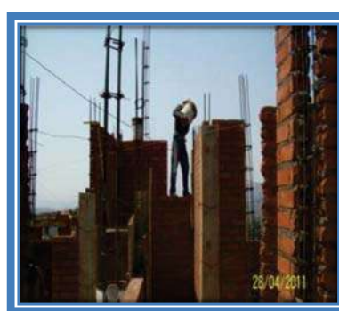
CONCRETO EN CASTILLOS
