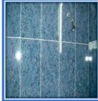
COLOCACION DE AZULEJO
