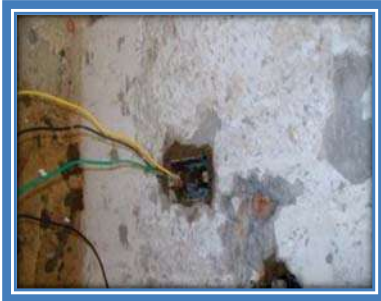
REHABILITACION SALIDA ELECTRICA
