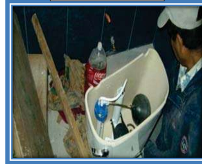
COLOCACION DE FLOTADORES
