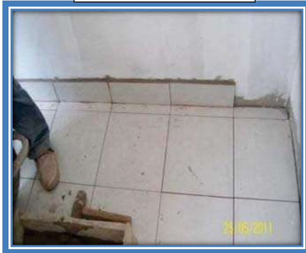
COLOCACION DE PISO Y ZOCLO
