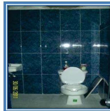
COLOCACION DE INODORO
