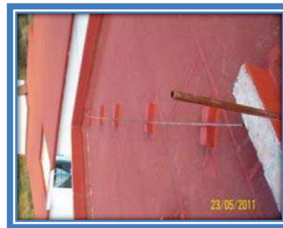
IMPERMEABILIZANTE EN LOSA
