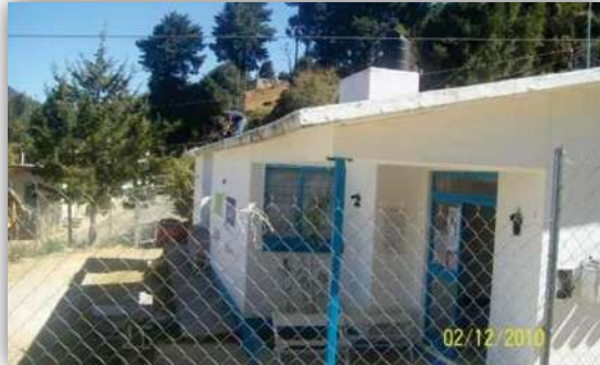
FACHADA PRINCIPAL ANTES DE LA OBRA
