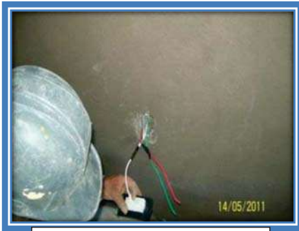
COLOCACION DE CONTACTOS Y APAGADORES
