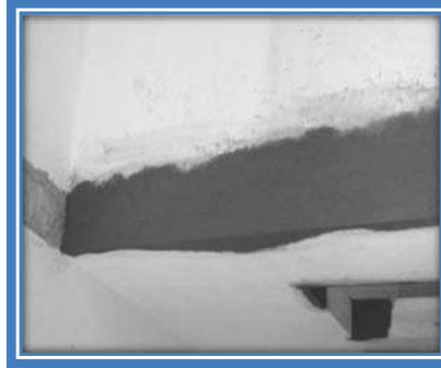
RESANES EN MUROS
