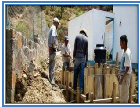
CISTERNA DE CONCRETO
