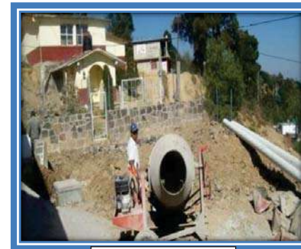
CONCRETO HECHO EN OBRA
