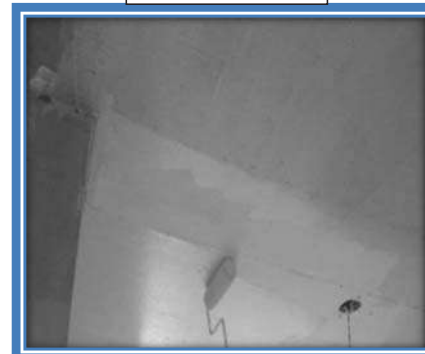
PINTURA EN PLAFONES
