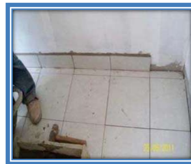
COLOCACION DE ZOCLO
