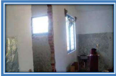
DEMOLICION DE MUROS
