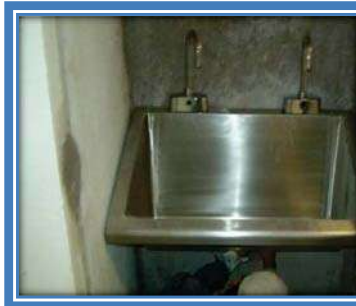
COLOCACION DE LAVABO CON LLAVE ELECTRONICAS PARA CIRUJANOS
