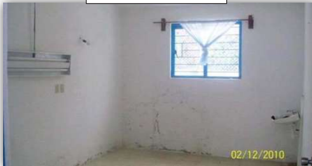
INTERIORES ANTES DE LA OBRA
