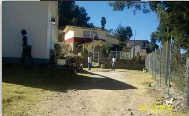
VISTA GENERAL ANTES DE LA OBRA
