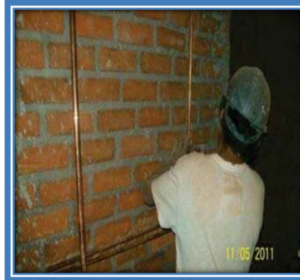
SALIDAS DE GAS PARA ESTUFA
