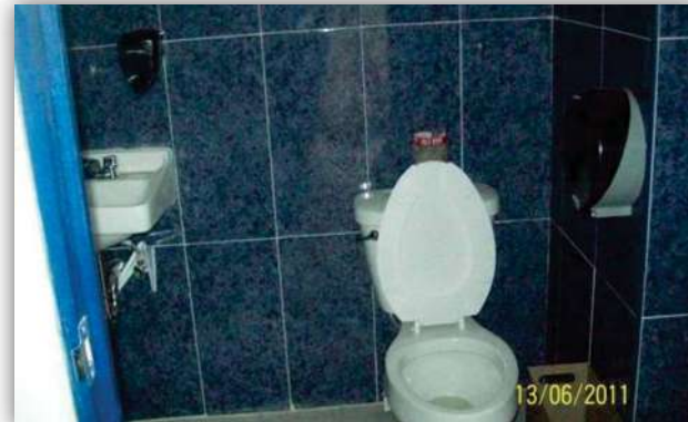
INTERIORES DESPUES DE LA OBRA
