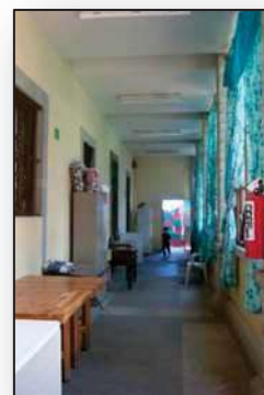
142. Área de talleres y planchado viendo al sur. B.U.
