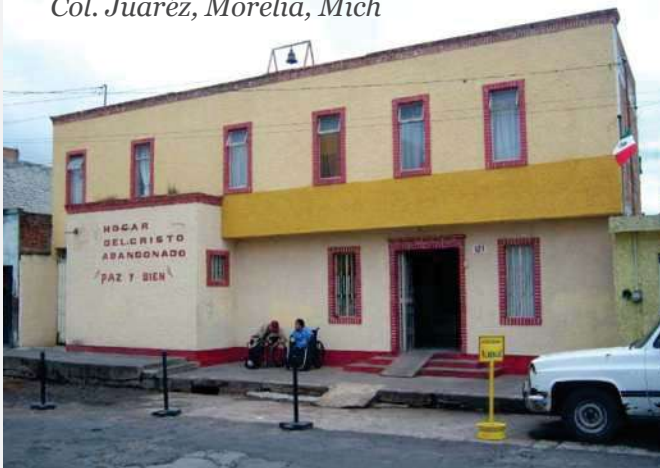
75.- Fachada principal del albergue. Briseida Uribe
