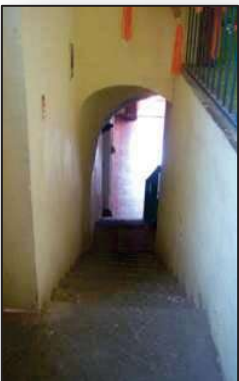
129. Escaleras de acceso al albergue. Briseida Uribe.
