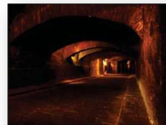
20.- Túneles de Guanajuato. http://farm3.static.flickr.com/2355/2217201353_8fd10b1c48.jpg
