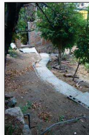
153. Vista hacia el acceso al refugio desde el terreno disponible. B.U.
