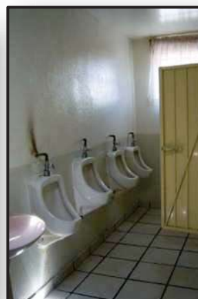
102. Sanitarios en planta alta. Briseida Uribe.
