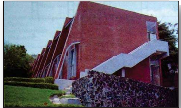
114. Vista de la fachada Sureste. René Escobar Alarcón.
