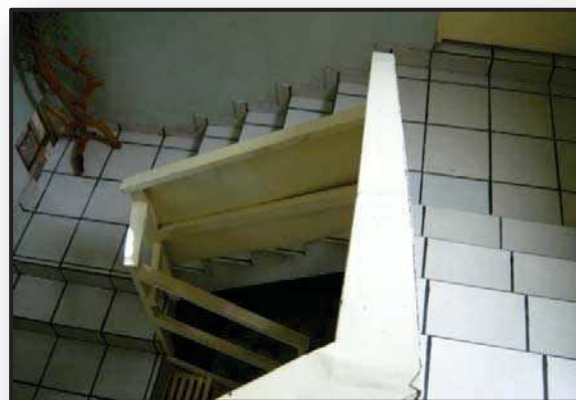
95. Escaleras. Briseida Uribe
