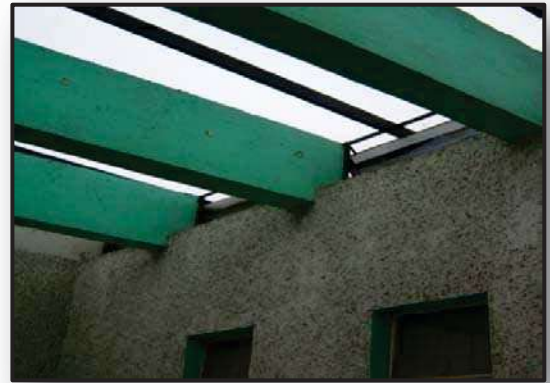
104. Cubierta de la sala de televisión.
