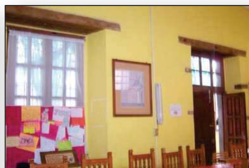
134. Ventana y puerta hacia el oeste del comedor. Briseida Uribe
