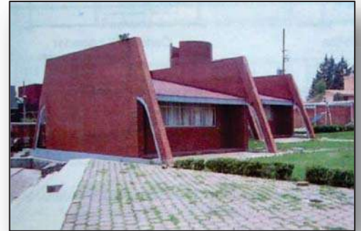
118. Vista de la fachada Sureste. René Escobar Alarcón
