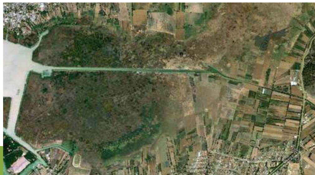
2.7 Vista aérea del Canal de Tzurumutaro. Fuente: GOOGLE EARTH
