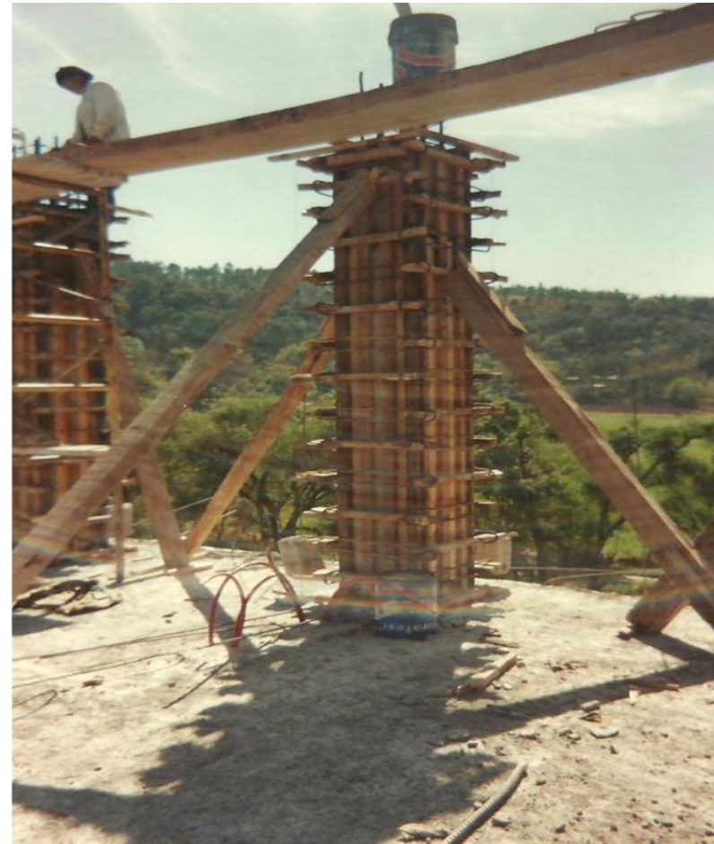
Cimbrado de columnas
