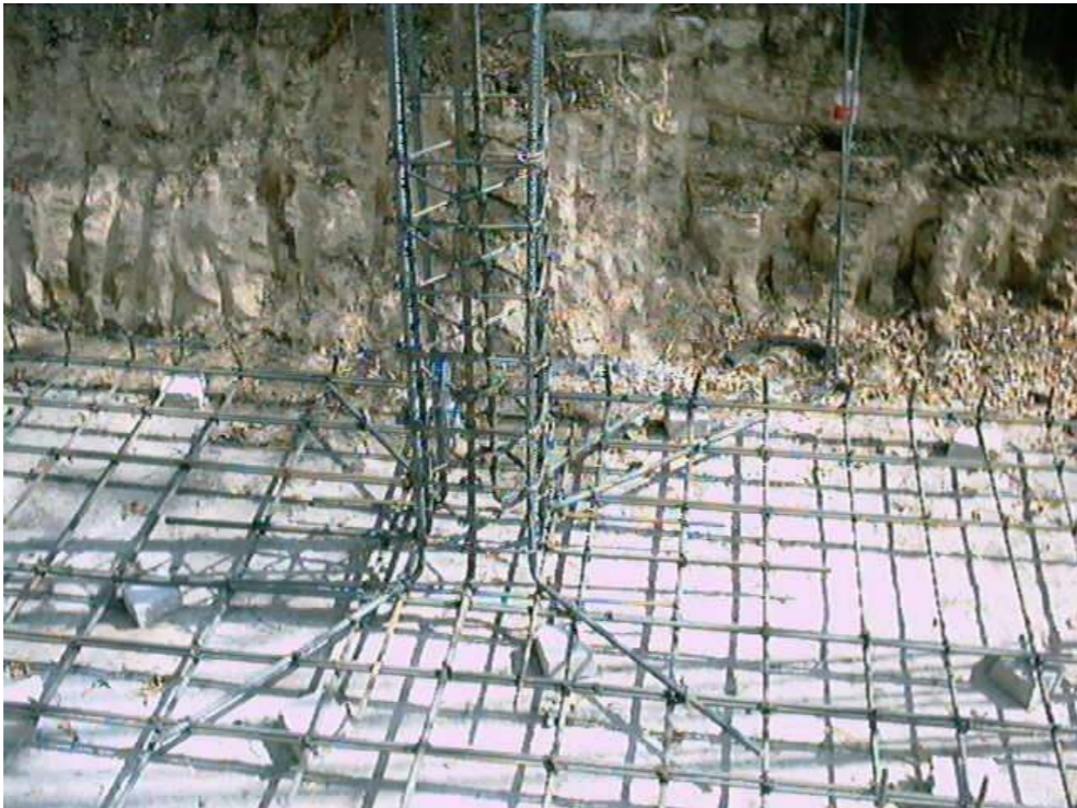
Armado de zapata y dado
