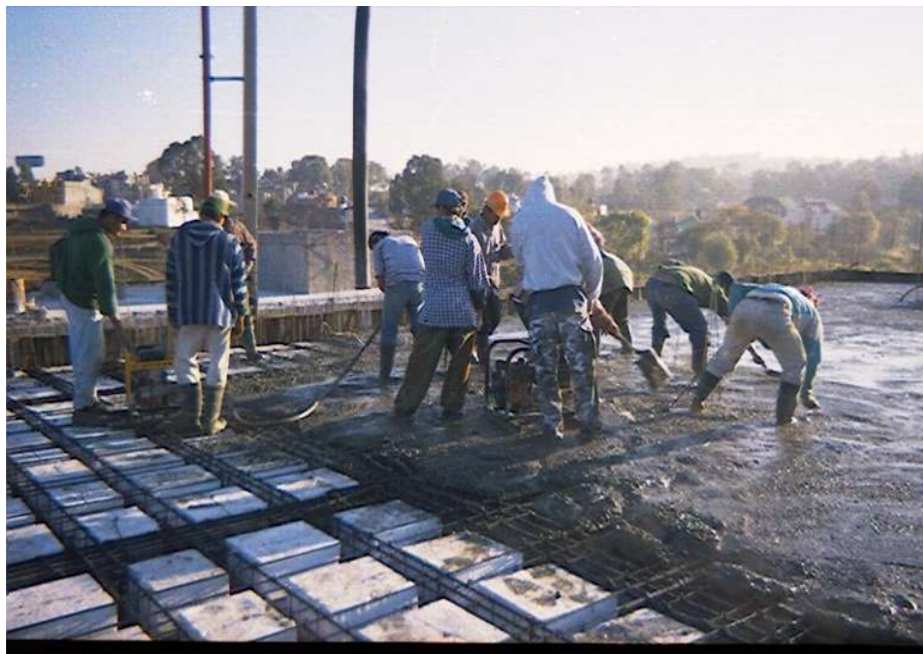
Colado y vibrado de losa de entepiso
