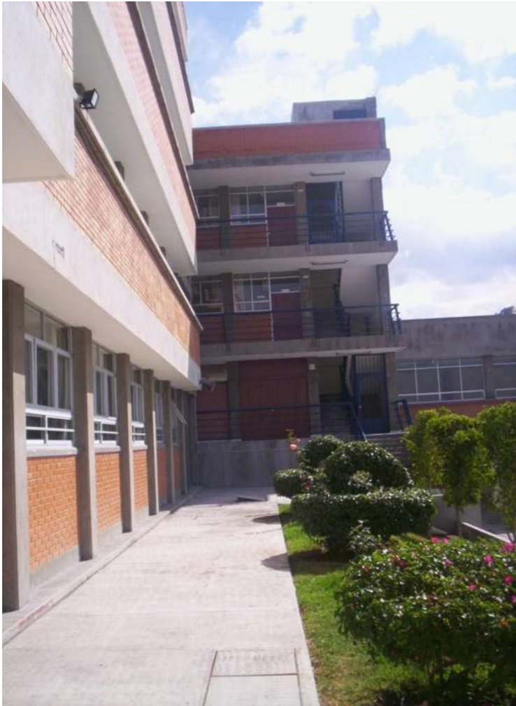
Vista sur edificio B
