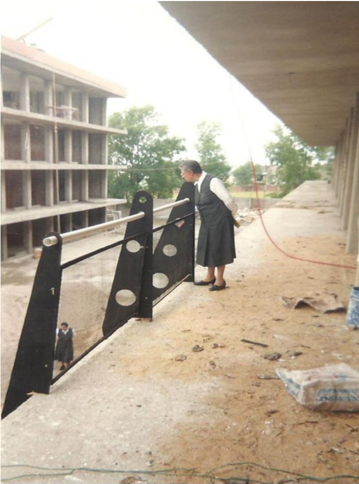
Detalle de barandal
