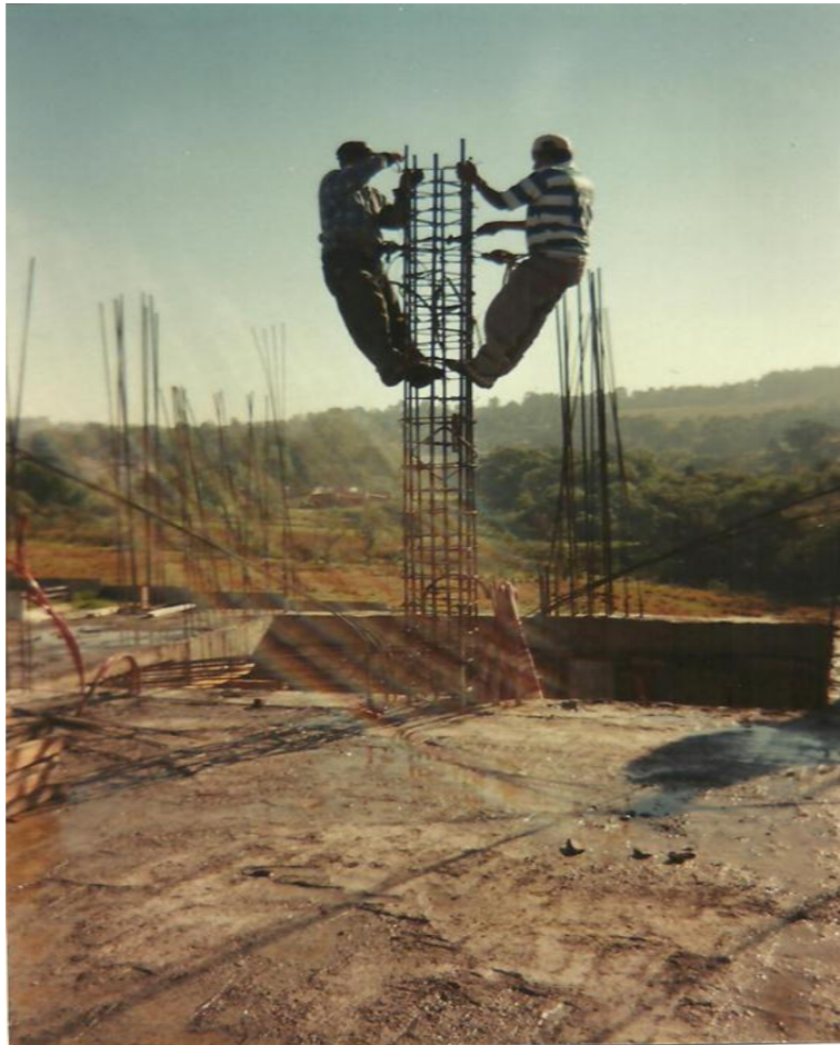
Armado de columnas
