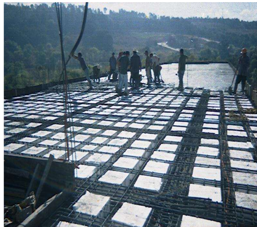
Colado de capa de compresión de 5 cm aprox.
