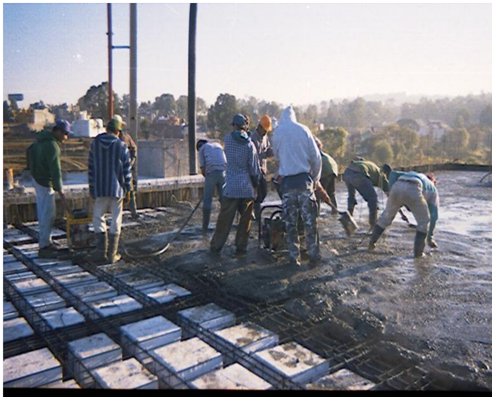
Colado y vibrado de losa de entrepiso
