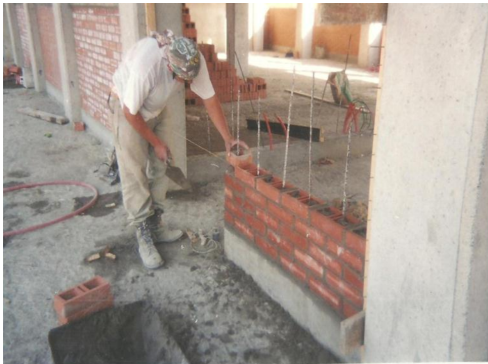
Muro de tabique extruido
