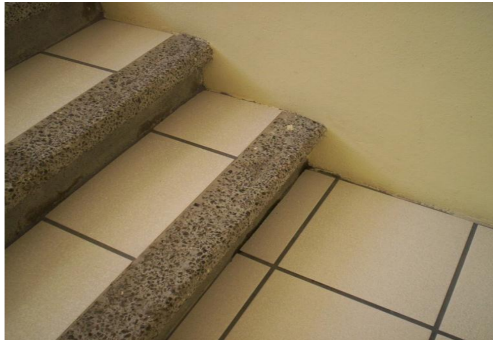
Detalle de escalón
