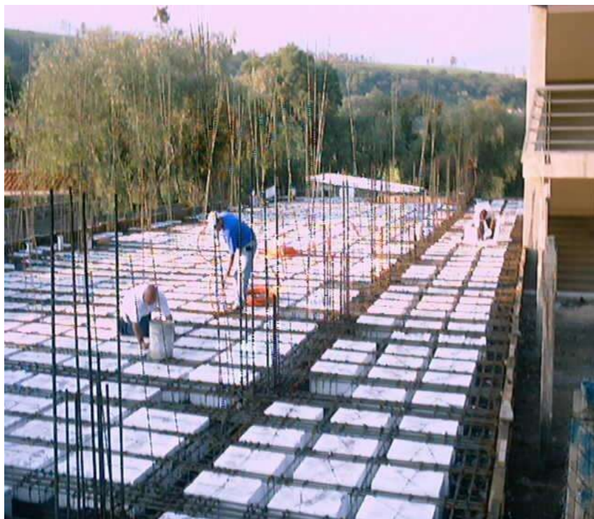
Colocación de elementos aligerantes en losas
