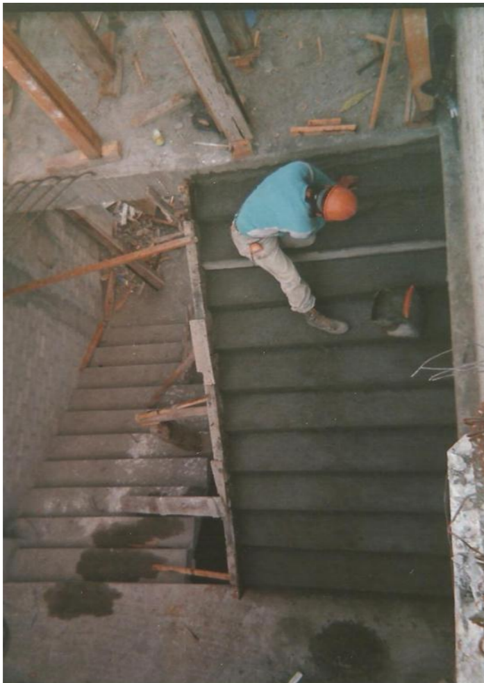
Forjado de escalera
