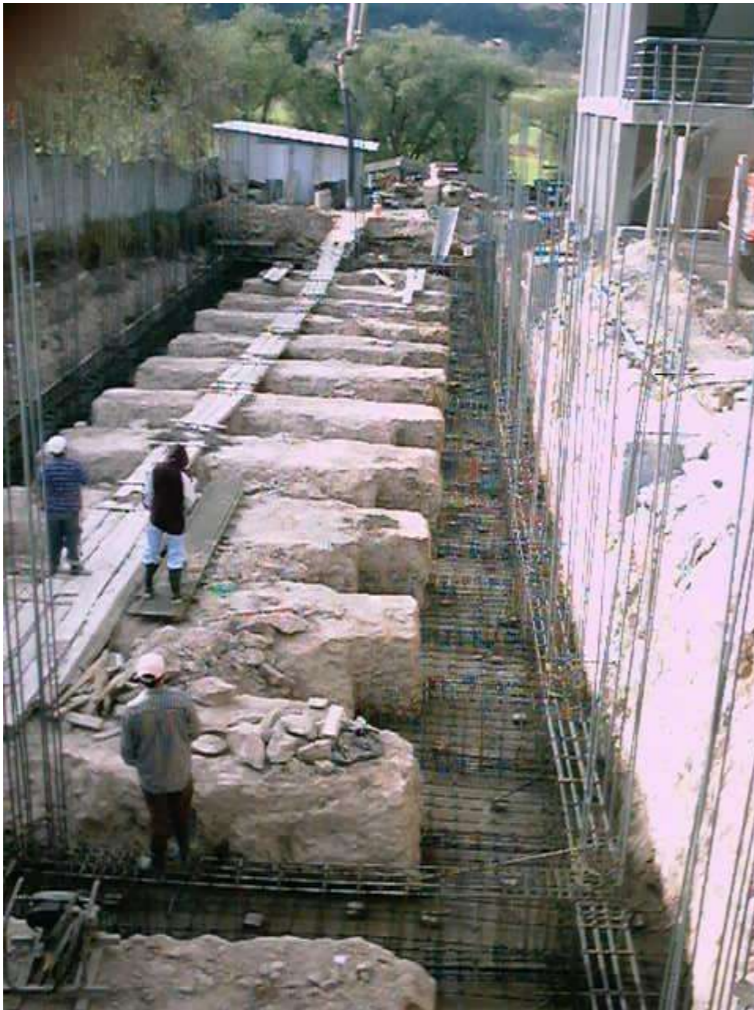
Vista de armado de traves y zapatas en edificio C
