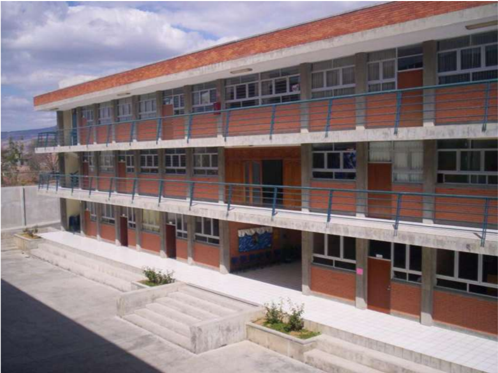
Vista sur edificio A principal
