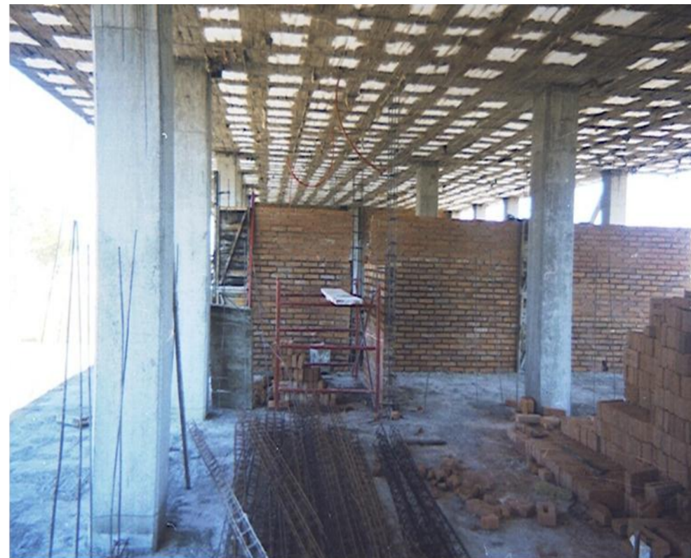
Colocación de muros divisorios en aulas
