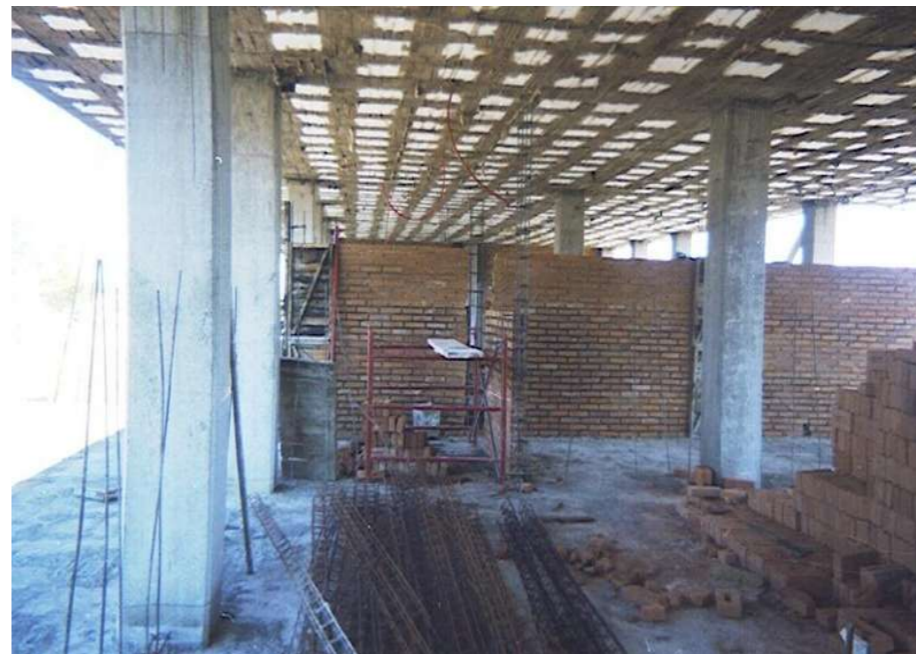
Losa decimbrada y colocación de muros de tabique rojo.
