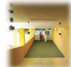
Foto 74. Cambio de acabado en piso
