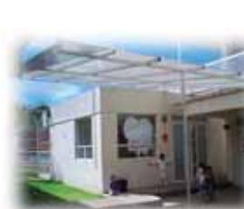
Foto 52. Cubierta en filtro y control
