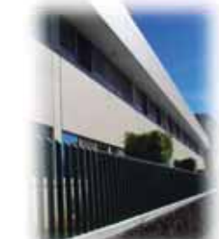
Foto 78. Fachada lateral de comedor
