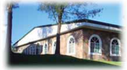
Foto 25. Fachada poniente del módulo principal.
