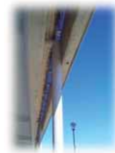
Foto 50. Falso pretil en losa a dos aguas
