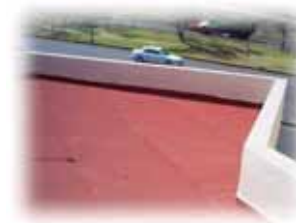
Foto 49. Pretil en losa plana
