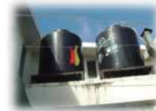
Foto 46. Azotea área de servicio
