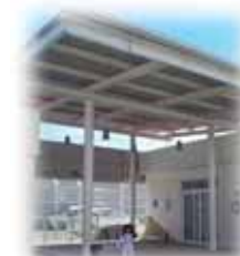
Foto 53. Cubierta en zona administrativa y de servicios
