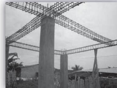
Figura 22. Sistema constructivo columna-trabe
