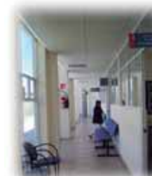
Foto 55. Pasillo en área médica y administrativa
