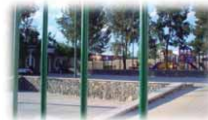
Foto 26. Muros de contención y rampas como consecuencia del desnivel
