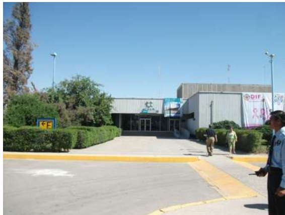
ACCESO A LAS INSTALACIONES INICIO DE LAS ACTIVIDADES DE REMODELACION
