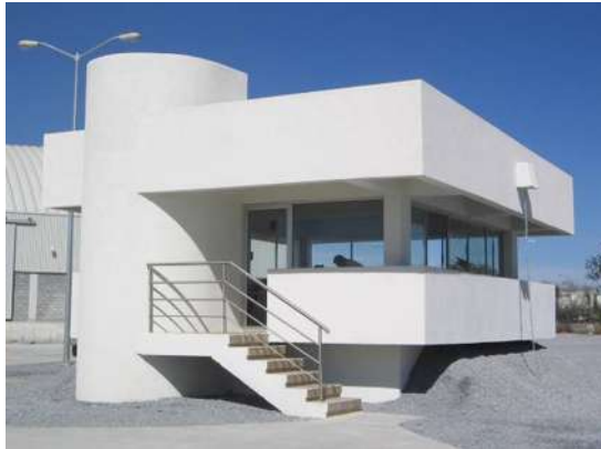
EDIFICIO TERMINADO OFICINAS ADMINISTRATIVAS
