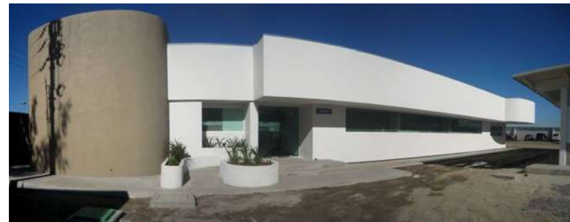
EDIFICIO TERMINADO OFICINAS DE LA ADMINISTRACION LOCAL DE JURIDICA
