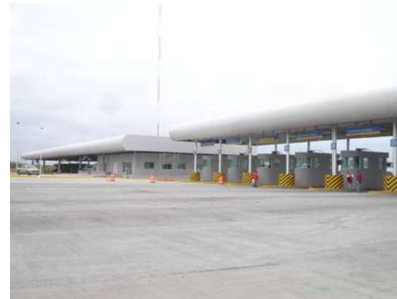
EDIFICIO TERMINADO OFICINAS ADMINISTRATIVAS – MODULOS DE IMPORTACION
