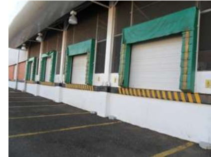
Anden de carga y descarga
