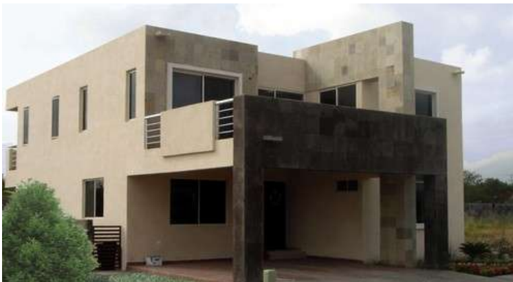
Fachada con cantera negra
