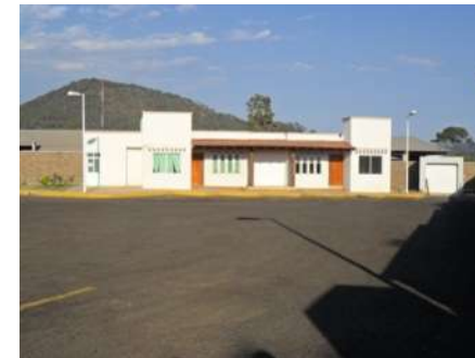
Patio de maniobras y departamentos de descanso para los choferes de tráiler
