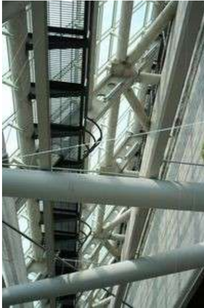
Estructura con viga boyd
