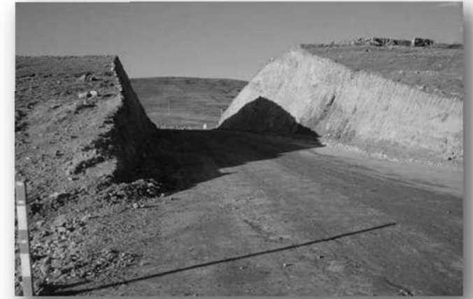
IMAGEN 24 y 25: Muestran cómo se realizan las estructuras terraplén, con el material extraído del terreno
