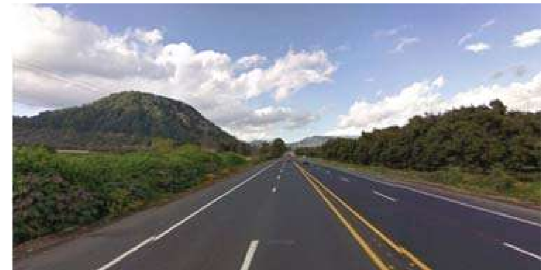
IMAGEN 46: Pavimentación carretera principal
