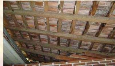
Fotografía 19. Cubierta a base de morillos y fajillas que sostienen teja de barro recocido. Foto. DDJ
