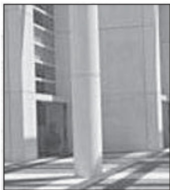
Fig. 47. TIPO DE COLUMNAS Al tener estructura de acero la construcción es con mayor rapidez.
