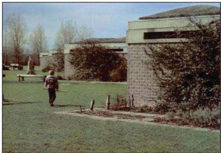
Fig. 25. EXTERIOR DEL EDIFICIO
