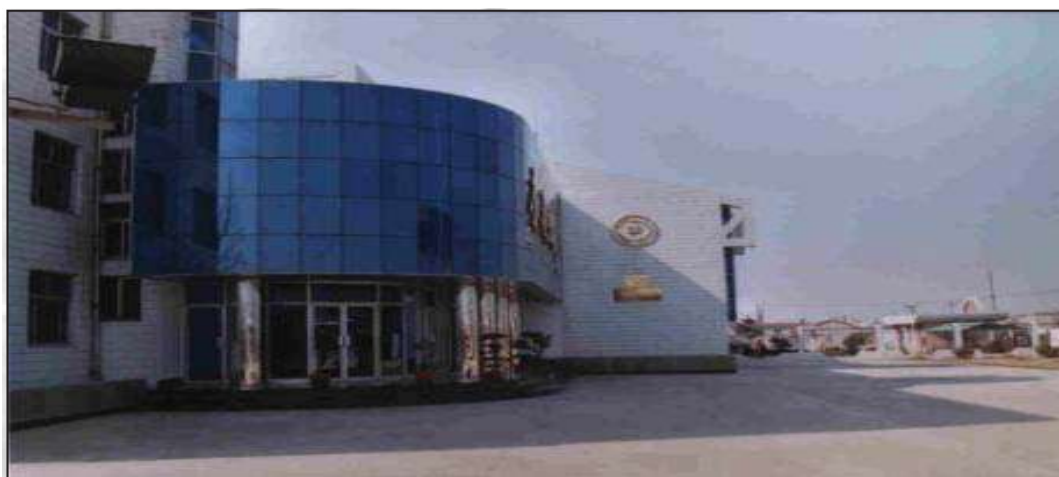
Fig. 16. ENTRADA AL EDIFICIO
