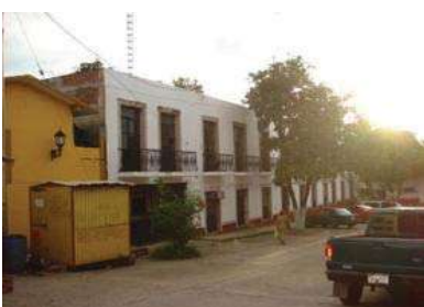
Vivienda de tabique
